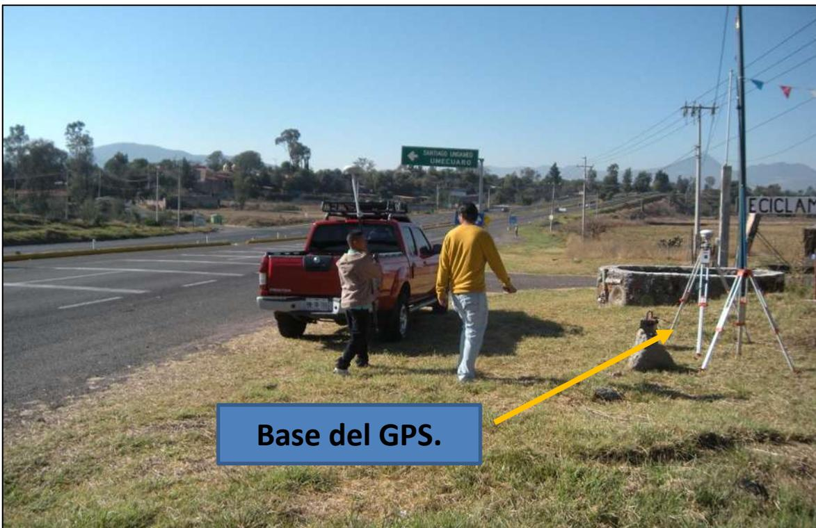
*Figura 4.20 Levantamiento de planimetría con equipo GPS (3). Fuente: propia.*
