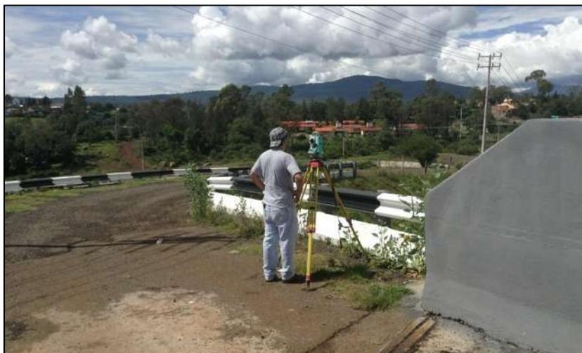
*Figura 4.30 Levantamiento topográfico con estación total (5). Fuente: propia.*
