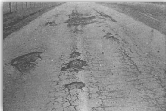
Figura B.2. Levantamiento por congelación.
