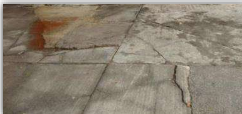
Figura B.18. Levantamiento localizado.
