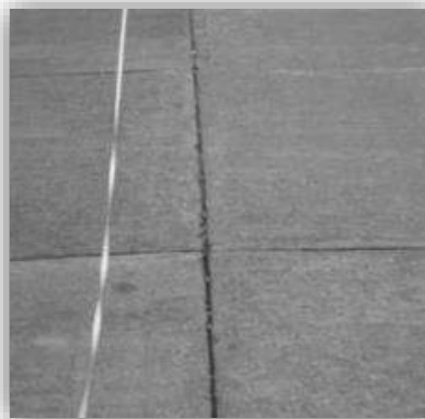
Figura B.8. Separación de la junta longitudinal.
