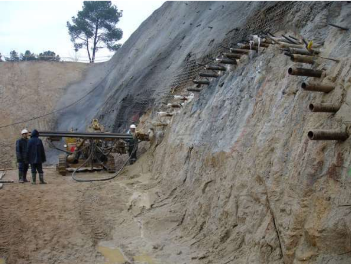
Figura 4.3 Inicio de la excavación del túnel (Enfilaje).
