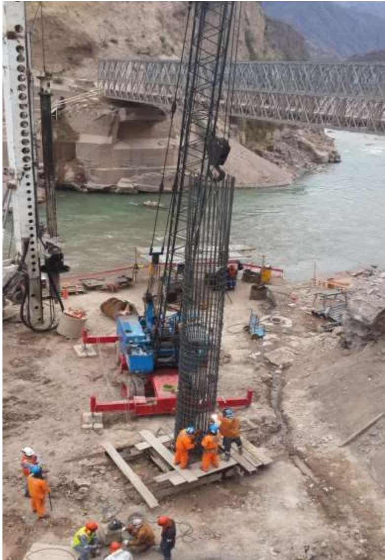
Figura 3.6 Perforación para cimentación profunda.
