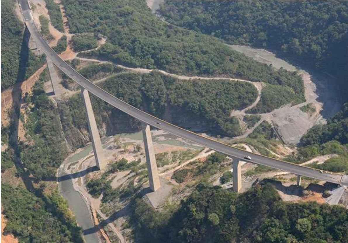
Figura 4.1 Puente doble voladizo Gilberto Borja Navarrete.
