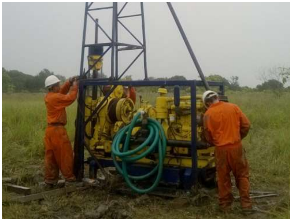
Figura 1.2 Trabajos de perforación y muestreo para penetración estándar.
