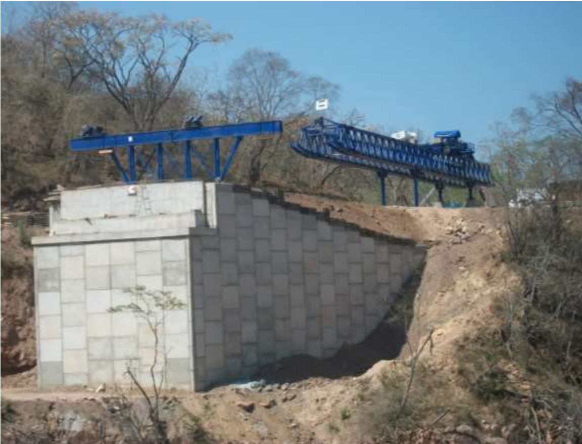
Figura 4.6 Construcción de Muro mecánicamente estabilizado.
