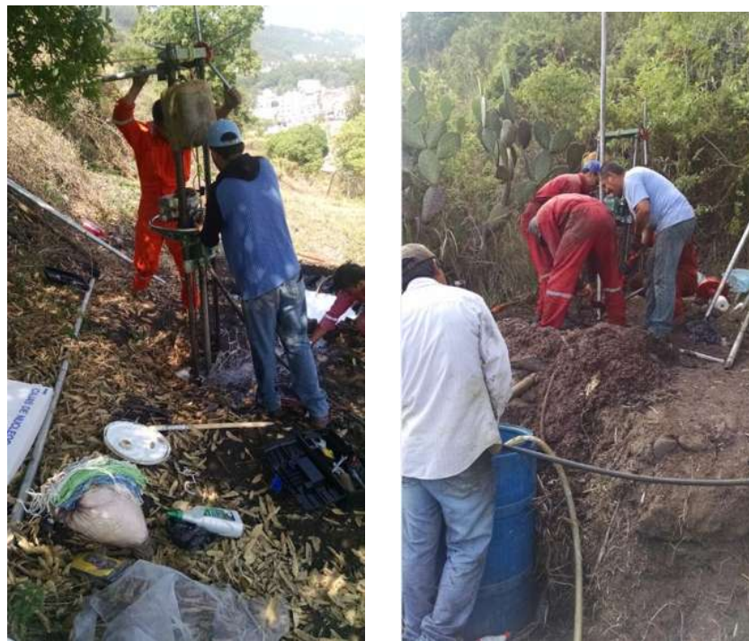
Figura 0-1. Perforación del sondeo 2 (izquierda) y sondeo 3 (derecha) en el portal de salida del túnel II.
