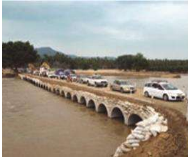
Figura.1.2 Paso provisional, puente Coyuca I.
