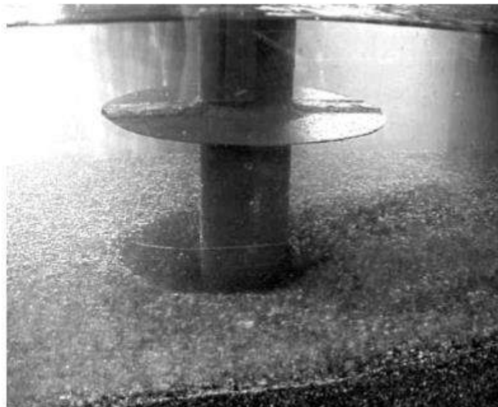
Figura 2.10 Desarrollo de la socavación en la pila con el aro. Moncada A.(2007)
