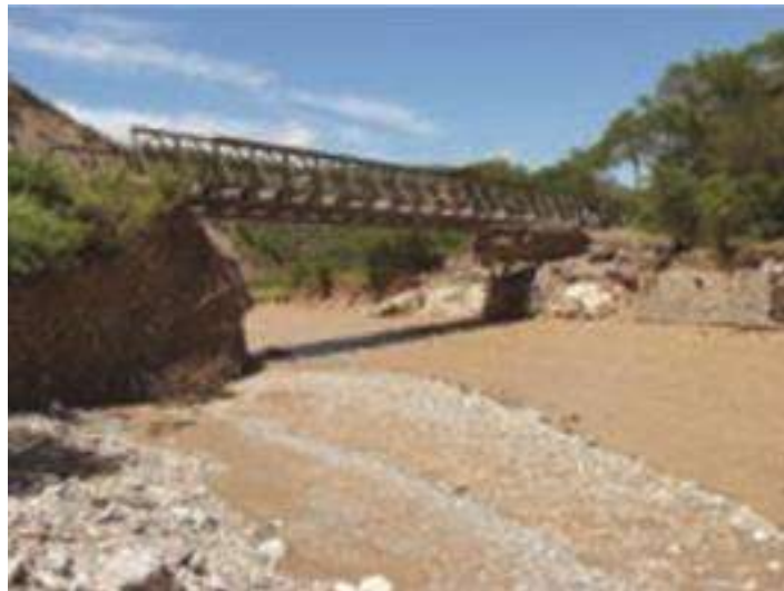
Figura.1.3 Colocación de puente tipo Bailey en el puente Del Canal
