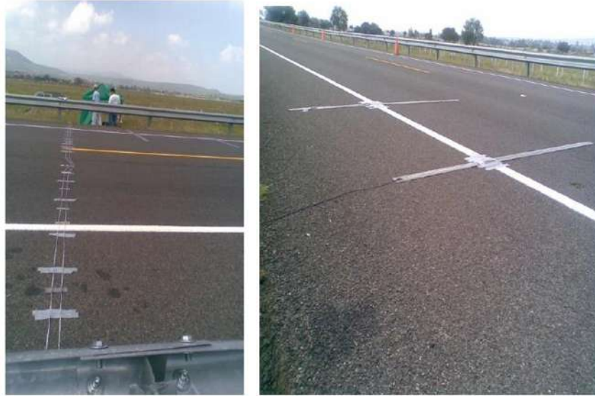
Figura 5.- Cableado y Sensores Piezoeléctricos.
