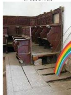
El piso de este espacio es de loseta de barro de 25x25 cm., colocada a 45°; en la parte central se encuentra una sección de 2.30 x 2.30 mt., recubierta con tabloncillos de madera. Ambos materiales presentan deterioros dada su antigüedad y el estado de abandono en el que se
