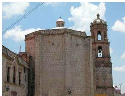
Figura 5.11 Contrafuertes del ábside.
