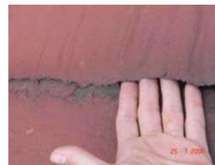
Ruptura de membrana
