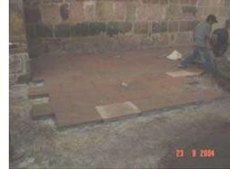
Baldosa sobre firme de concreto armado. (plazoleta norte)
