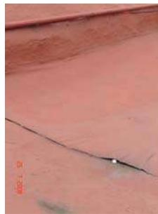
Desprendimiento de membrana de impermeabilización
