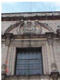
Imagen 4.1. Detalle del cerramiento o platabanda de la ventana coral y de la capilla lateral.
