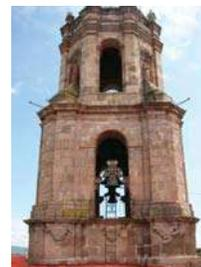
A diferencia de estos, en los vanos de ventanas que se ubican sobre el paramento norte (imagen 4.3 y 4.5) y sur (imagen 4.4), no se aprecia una estereotomía adecuada para el cerramiento, por lo que se supone que estos pertenecen a una etapa constructiva posterior a la fábrica del templo. Además la cancelería en estos vanos está dispuesta sobre el paramento interior y no en el exterior como en la fachada principal.
