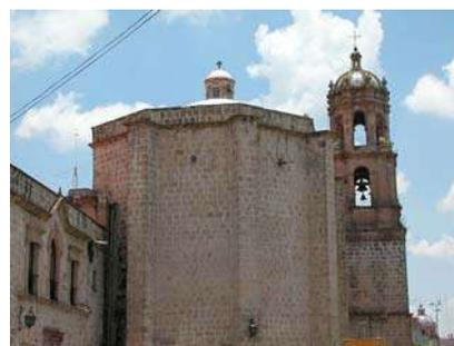
Fig. 5.44 Sistema de contrafuertes
