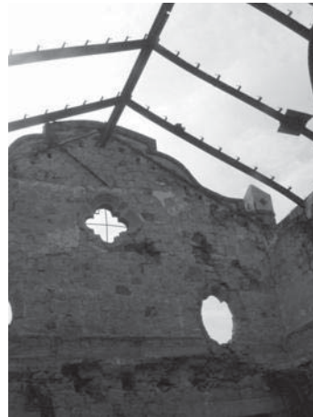
Edificio A, espacio A6
