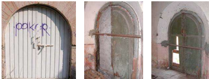
Fotos de las puertas del cuerpo A del edificio del molino. (P01, P03 y P02). Fotografía Yunuén Y. Barrios Muñoz.
