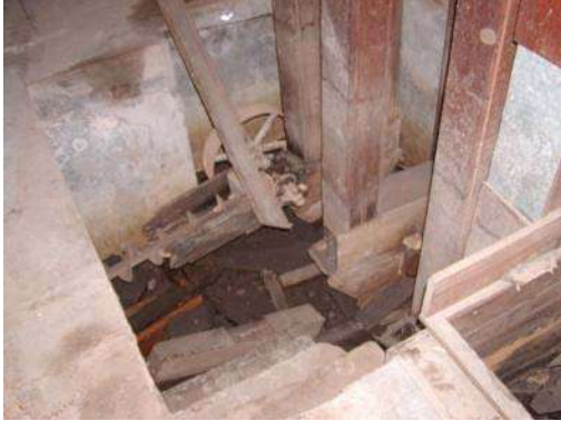
Edificio A, espacio A2
