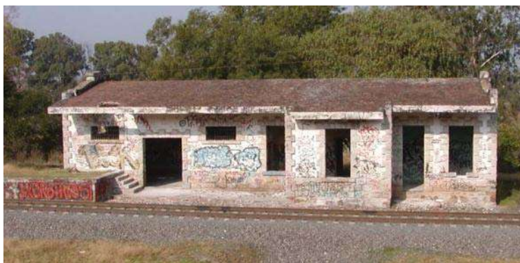
Foto de la estación de ferrocarril "La Huerta", actualmente fuera de los terrenos de la Escuela. Fotografía Yunuén Y. Barrios Muñoz. Febrero del 2005.
