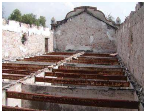
Edificio B, espacio B1
