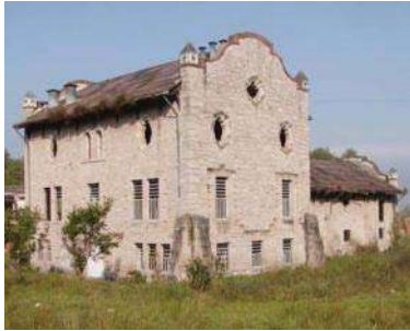
Edificio del molino 2005.
