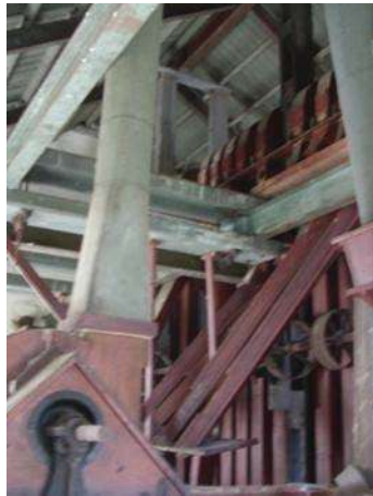
Edificio A, espacio A6
