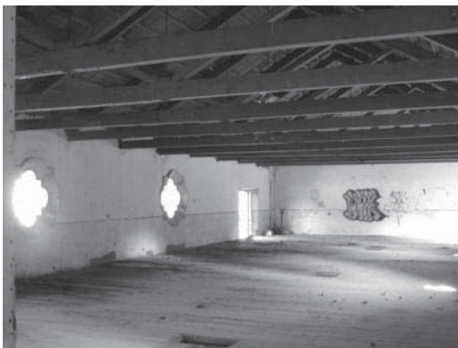
Edificio B, espacio B2
