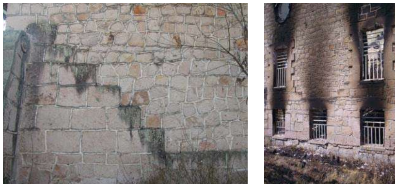
Foto de detalle de la estereotomía de las piezas de cantería en fachadas
