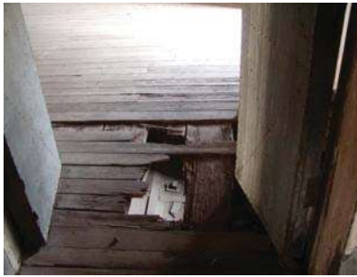
Foto Entrepiso del edificio B Fotografía Yunuén Y. Barrios Muñoz. Febrero del 2005
