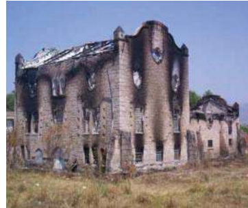
Edificio del molino 2006.
