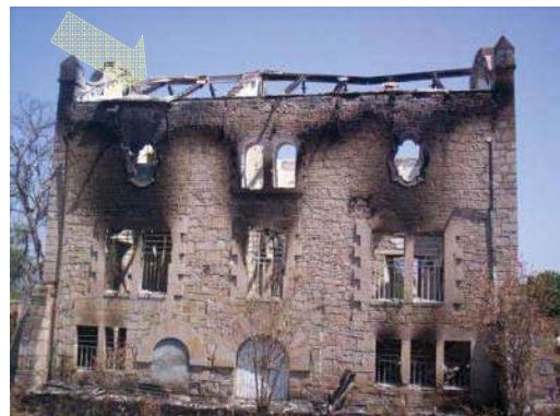
Fotos del inmueble antes del incendio y después del incendio en el que pierde cubiertas y entrepisos. Fotografía Yunuén Y. Barrios Muñoz. Diciembre del 2005 y Abril del 2006.
