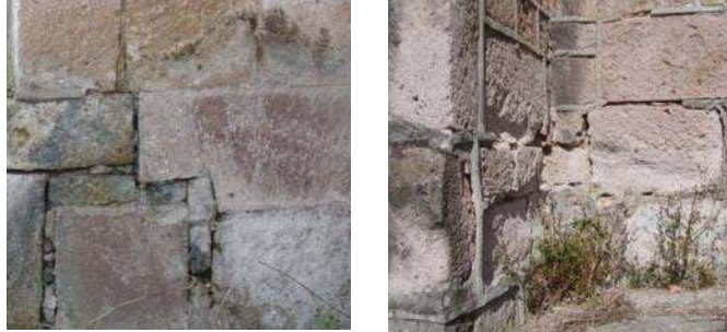
Foto 29. Detalle del sobrecimiento. Fotografía Yunuén Y. Barrios Muñoz
