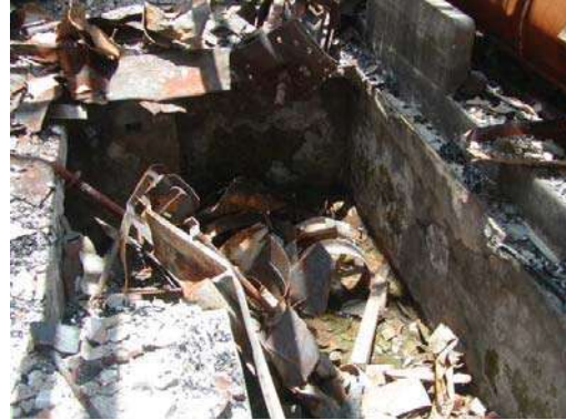
Edificio A, espacio A2
