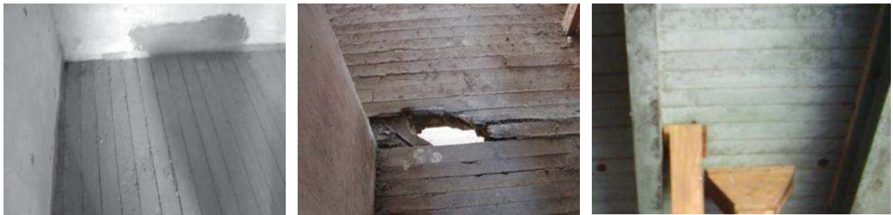
Fotos de detalles del bastidor de madera de los entrepisos. Fotografía Yunuén Y. Barrios Muñoz. Fotos tomadas en febrero del 2006.
