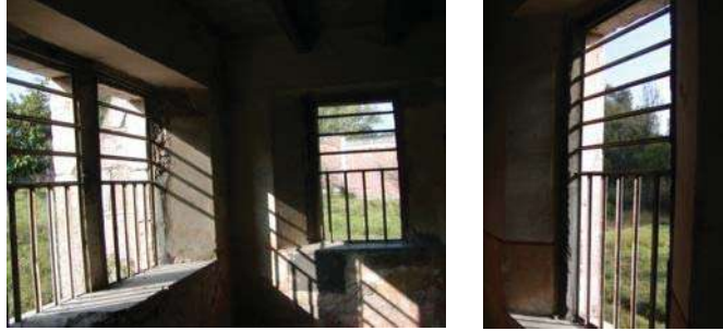
Fotos de herrería en vanos interiores. Fotografía Yunuén Y. Barrios Muñoz. Febrero 2005.
