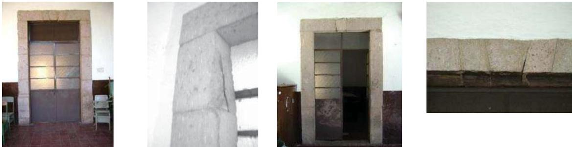
Dovelas con un corte mal logrado y pérdida de juntas
