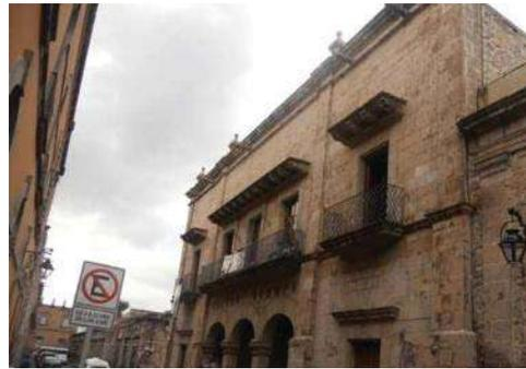
Muros construidos con piedra de cantera con labrado detallado a manera de aparente.
