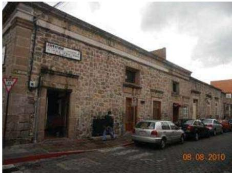
Muros construidos con piedra de cantera con labrado rustico.
