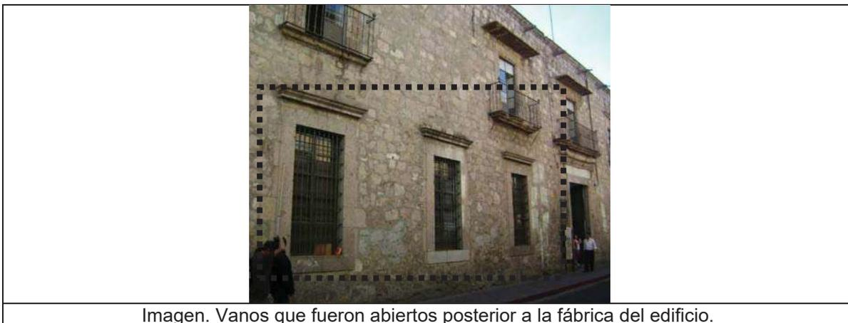
Imagen. Vanos que fueron abiertos posterior a la fábrica del edificio.
