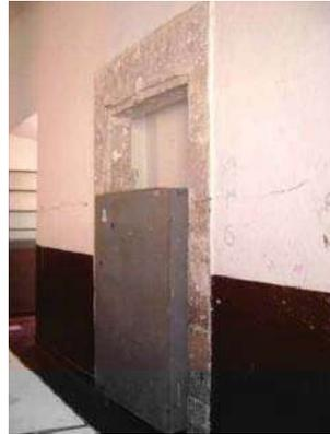
Imagen 8. Alteración física. Aplicación de pintura vinílica sobre aplanados de mortero de cal.
