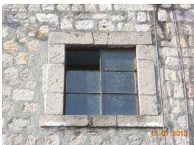
Instalaciones aparentes. Vanos sin proporción y con un trabajo de labrado mal logrado.
