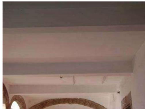
Corredor oriente. Vigería y losa de concreto.
