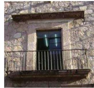
Posteriormente para 1751, durante el mismo siglo, se abren en planta baja otros vanos para servicio a accesorias, es posible identificarlos fácilmente por el labrado tosco de las dovelas y piezas que conforman los enmarcamientos y que pueden identificarse sobre la fachada norte donde se visualizan vestigios de dos de estos enmarcamientos.
