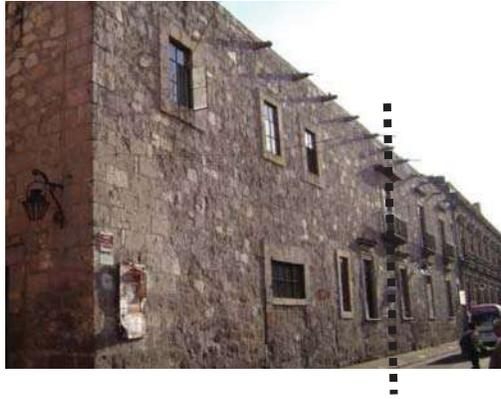
Imagen. Enmarcamiento ubicado a la mitad del edificio sobre planta alta, el vano se observa que es el original de fábrica por la disposición de las piezas que forman el enmarcamiento.
