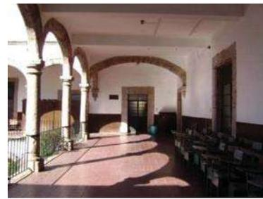
Corredor oriente, planta alta. Apoyos corridos, apoyos aislados, cubierta de losa y traveses de concreto. [enero 2010]
