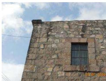
Vanos sin proporción y con un trabajo de labrado mal logrado.
