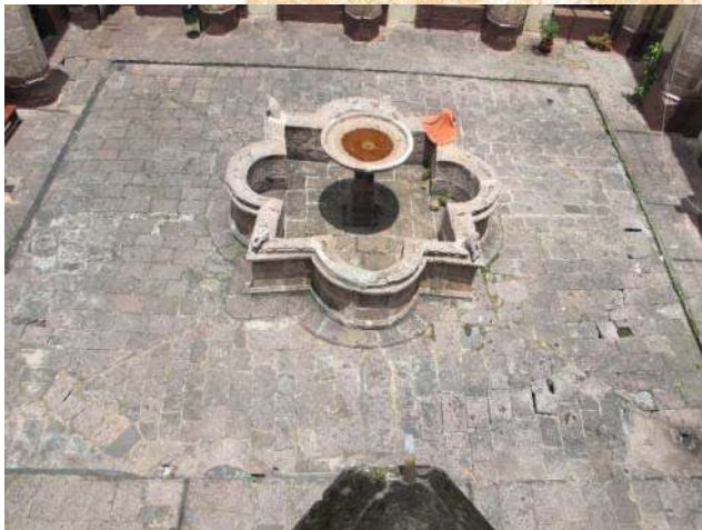
Figura No. 31: Muestra el estado deteriorado del las piezas del patio. Foto: E. L. Torres, P. C., 2010.
