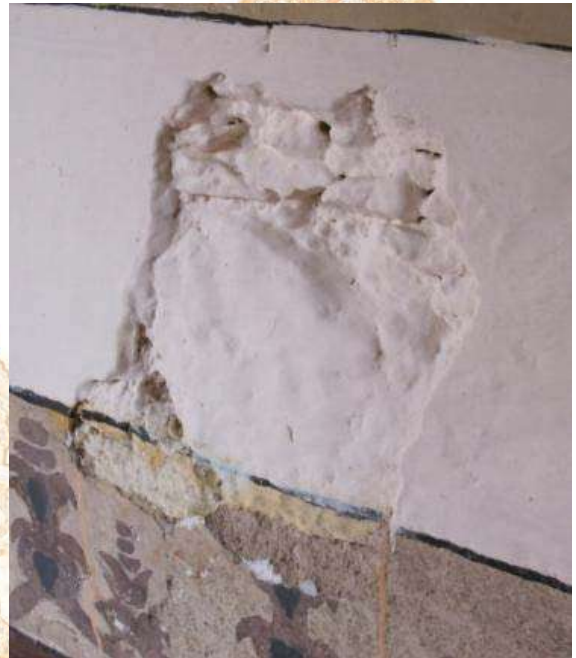
Figura No. 34: Muestra las malas intervenciones y la constitución del muro. Foto: E. L. Torres, P. C., 2010.
