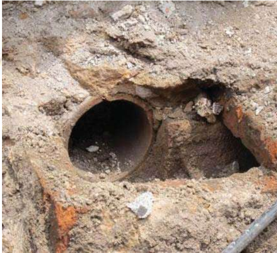
Figuras No. 28 y 29: Muestran las instalaciones que posiblemente sean las originales, con piezas de barro rojo recocido. Fotos: E. L. Torres, P. C., 2010.
