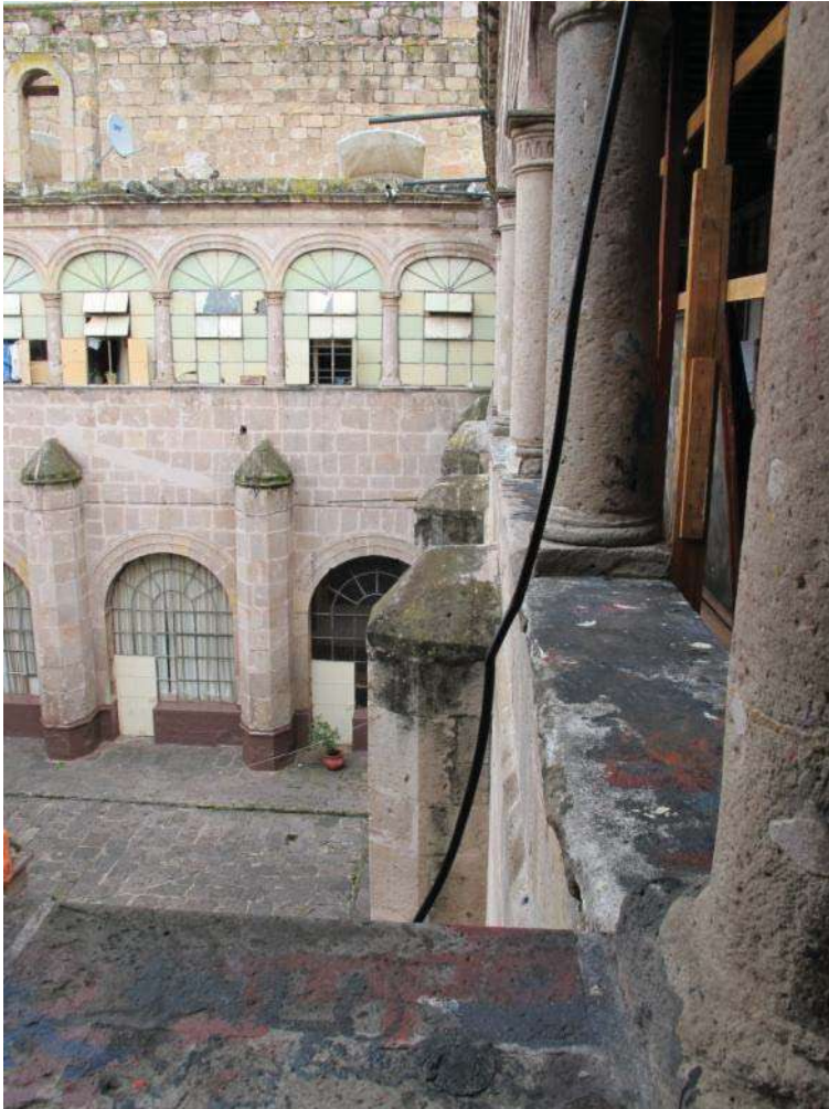
Figura No. 17: Muestra el desplome del muro oriente, contrarrestado en parte por los contrafuertes. Foto: E. L. Torres, P. C., 2010.
