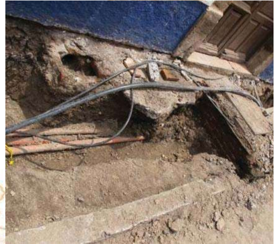
Figuras No. 28 y 29: Muestran las instalaciones que posiblemente sean las originales, con piezas de barro rojo recocido. Fotos: E. L. Torres, P. C., 2010.
