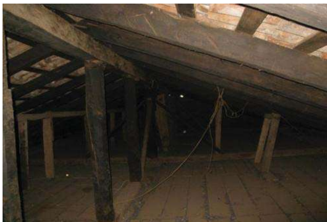
IMAGEN 87.- Estructura de "par e hilera". Se observa la madera seca y sana. (Foto: J.A.P.I, agosto 2010)
