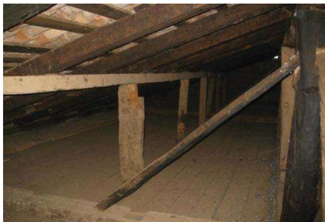
IMAGEN 88.- Jabalcón improvisado para evitar la deformación de vigas pares.(Foto: J.A.P.I, enero 2010)
