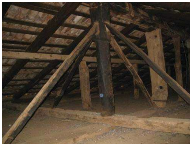
IMAGEN 75.- Techumbre a dos aguas soportada por vigas pares y sistema a base de puntales de forma tronco piramidal (Foto: J.A.P.I, agosto 2010)
