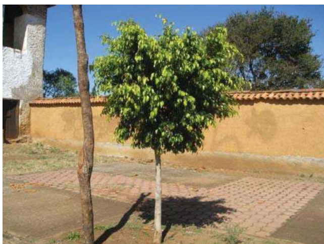
IMAGEN 30.-Borda atrial construida con el apoyo de fondos federales FOREMOBA (Foto: J.A.P.I, noviembre 2009)
