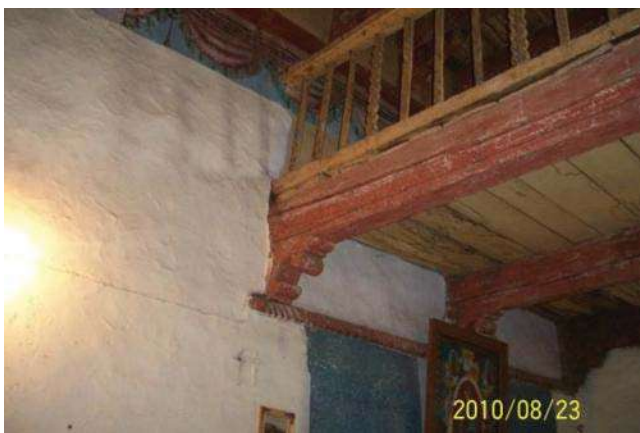
IMAGEN 14.- Coro a base de vigería de madera en el poniente del interior del Templo. (Foto: J.A.P.I, enero 2010)
