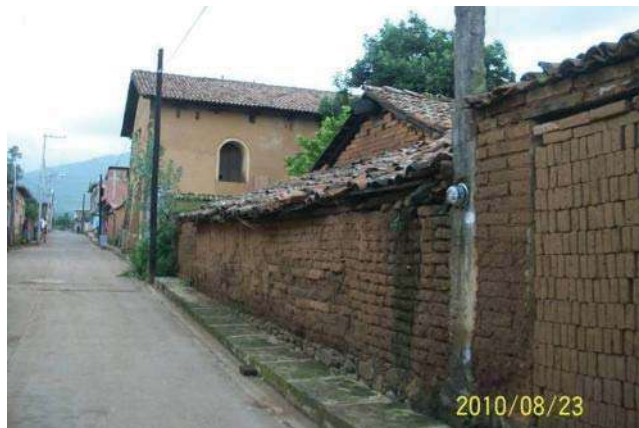
IMAGEN 49.- En varios casos los muros no cuentan con ningún tipo de aplanado.(Foto: J.A.P.I, agosto 2010)
