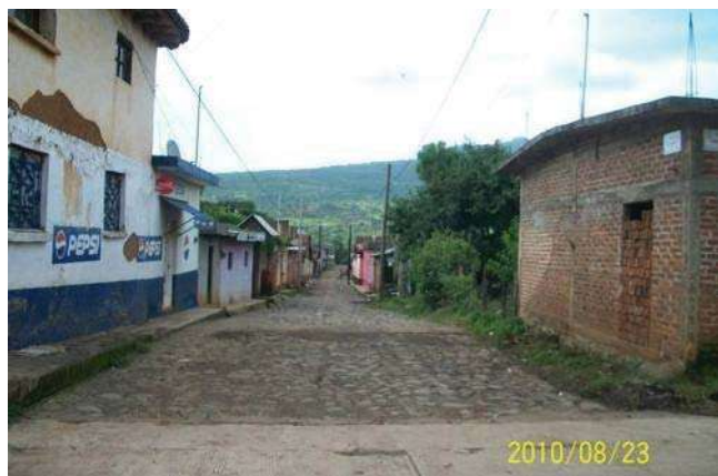
IMAGEN 46.- Pavimento en piedra braza, calle Guerrero en Santo Tomás. (Foto: J.A.P.I, agosto 2010)
