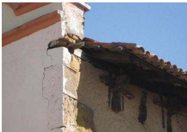
IMAGEN 84.- Aparejo de mampostería a manera de cadena de ángulo. (Foto: J.A.P.I, enero 2010)
