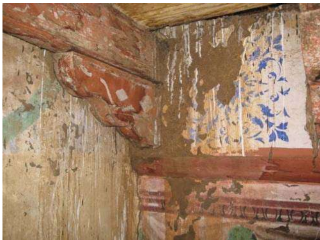
IMAGEN 76.- Viga de arrastre en forma de pecho de paloma (Foto: J.A.P.I, agosto 2010)
