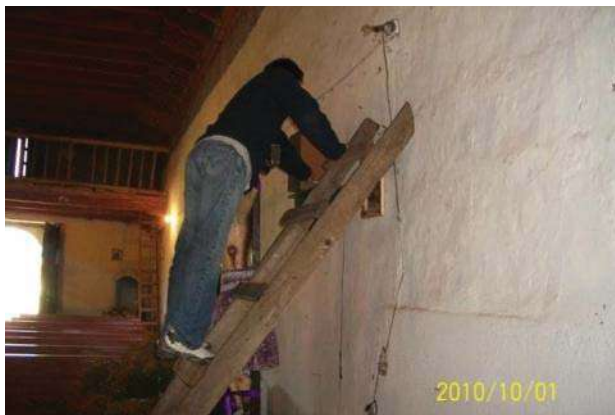
IMÁGENES 57 Y 58 .- Se aprecia el montaje de los hobos en el área correspondiente a la nave principal en los muros norte y sur respectivamente (Foto: J.A.P.I, octubre 2010)
