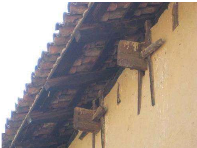
IMAGEN 74.- Sistema de tensores en maderas del Templo. (Foto: J.A.P.I, agosto 2010)
