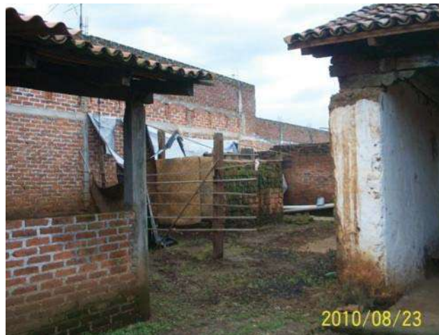
IMAGEN 79.- Vista de la letrina al interior del patio del conjunto religioso. (Foto: J.A.P.I, agosto 2010)
