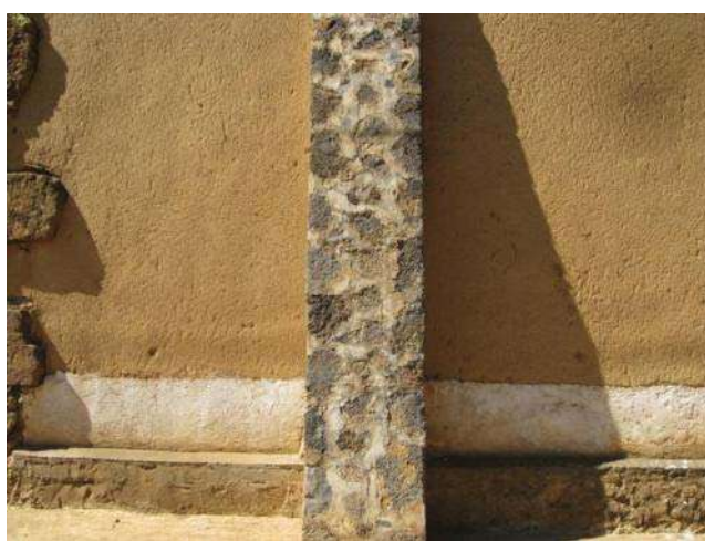
IMAGEN 29.-Esbeltos contrafuertes integrados en la década de los 90's. (Foto: J.A.P.I, noviembre 2009)
