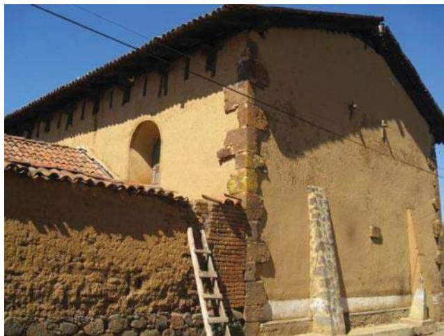
IMAGEN 11.- Cadena de ángulo y ligeros contrafuertes complementan los muros del Templo. Esquina sureste (Foto: J.A.P.I, enero 2010)
