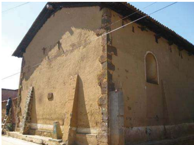
IMAGEN 78.- ubicación del hidrante comunitario, actualmente cancelado. (Foto: J.A.P.I, agosto 2010)
