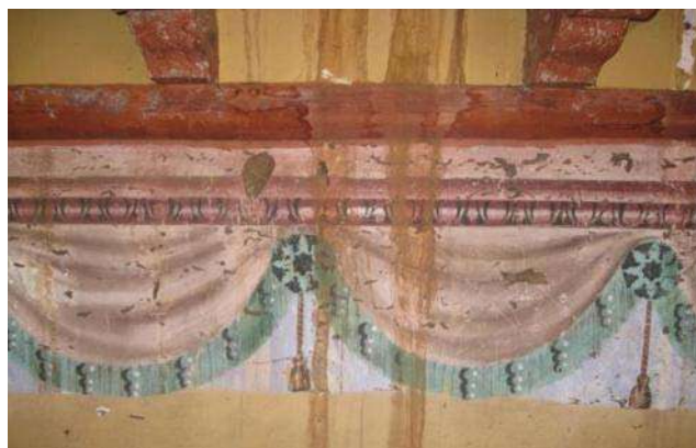
IMAGEN 94.- Esgurrimientos de arcillas en la parte alta de los muros del Templo. (Foto: J.A.P.I, agosto 2010)
