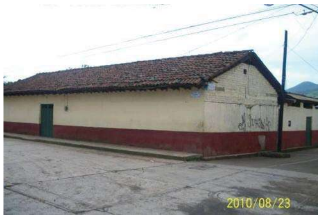
IMAGEN 43.- Predominio de macizo sobre el vano en las edificaciones vernáculas. (Foto: J.A.P.I, agosto 2010)
