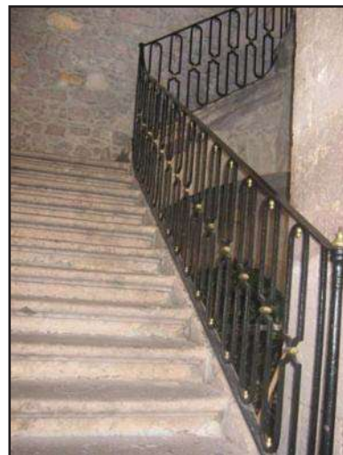
Imagen 67: panorámica de la escalera principal, se observa el barandal adosado a los escalones, de hierro forjado. (Foto: José A. Morales A.)
