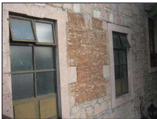
Imagen 68: panorámica de las ventanas del baño en planta alta, se observa la colocación de ventanas de herrería. (Foto: José A. Morales A.)
