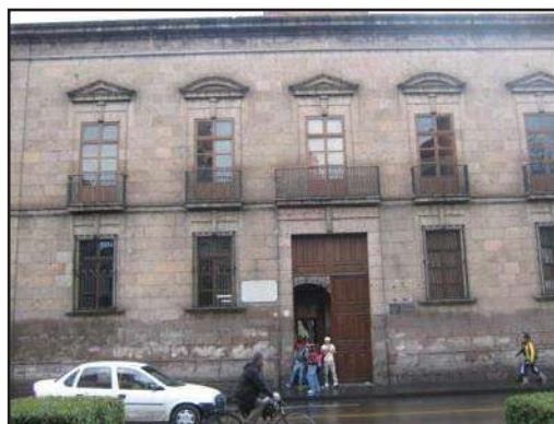
Imagen 64: de panorámica del área de la fachada, se observa el portón de acceso y las ventanas con vidriaría. (Foto: José A. Morales A.)
