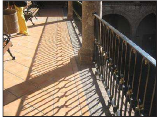
Imagen 114: Foto de piso de loseta cerámica, en corredores del segundo piso. (Foto: José Antonio Morales A.)
