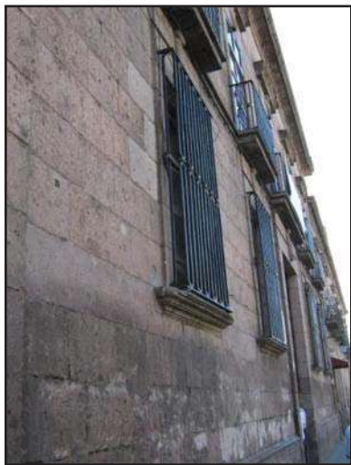
Imagen 65: panorámica de la fachada principal, se observan las protecciones de hierro forjado adosadas al muro de cantería. (Foto: José A. Morales A.)
