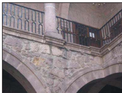
Imagen 133: Foto panorámica del barandal en el corredor de planta alta, de hierro forjado. (Foto: José Antonio Morales A.)
