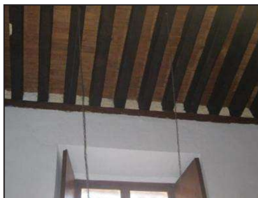
Imagen 44: de cerramiento con capitalizado al interior, acabado con mortero cal-arena, pintura vinílica. (Foto: José A. Morales A.)
