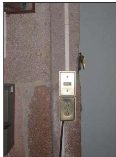
Imagen 59: interior, donde se observa la colocación y fijación de contacto y apagador sobre muro, en canaleta de plástico. (Foto: José A. Morales A.)
