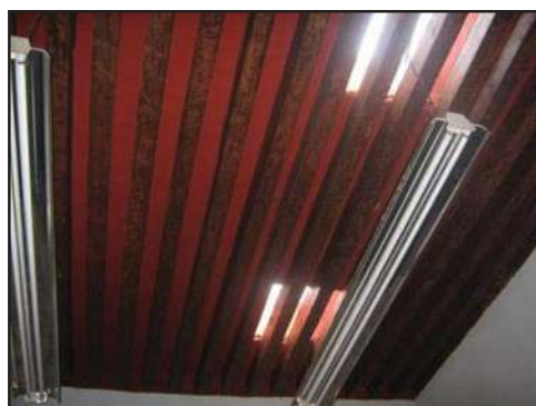
Imagen 167: Se observa la colocación de domos en la losa de azotea para dar iluminación y ventilación en los espacios B-7 y B7'. (Foto: José A. Morales A.)
