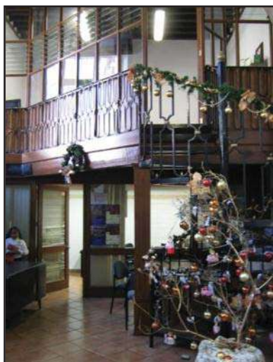
Imagen 127: Foto interior del área de la dirección, se observa la estructura del mezanine. (Foto: José Antonio Morales A.)
