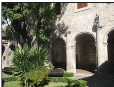
Imagen 34: panorámica del corredor Este en el segundo patio, se denota una composición simétrica. De la arquería de medio punto y las columnas de orden dórico. (Foto: José A. Morales A.)
