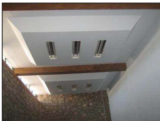
Imagen 53: del falso plafón, de la cubierta del espacio B-12. (Foto: José A. Morales A.)
