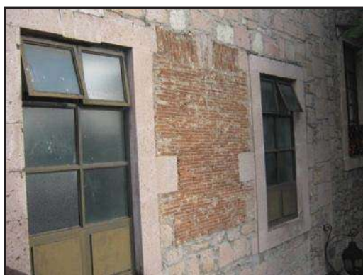
Imagen 132: Foto panorámica de las ventanas del baño en planta alta, se observa la colocación de ventanas de herrería. (Foto: José Antonio Morales A.)
