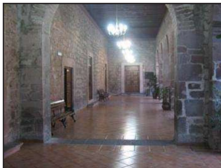
Imagen 86: Se observa el uso de lámparas para iluminación artificial en corredores: (Foto: José A. Morales A.)
