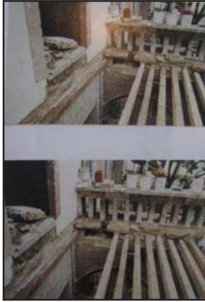
Imagen 3.- Foto del cambio de terrado y viguería del área de terraza del segundo patio. (Fuente: archivo del departamento de Patrimonio Universitario.)
