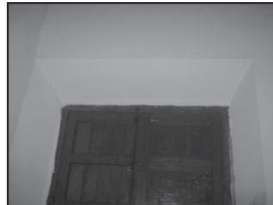
Imagen 32: del detalle del derrame y capialzado en jambas y platabanda en la parte interior. (Foto: José A. Morales A.)
