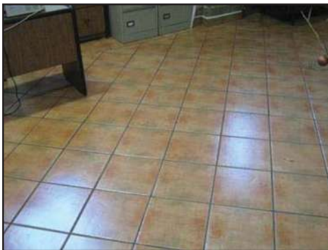
Imagen 170: Colocación de loseta cerámica en pisos interiores (Foto: José A. Morales A.)
