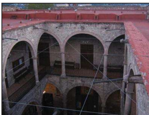
Imagen 57: panorámica de las gárgolas para el desalojo de aguas pluviales. (Foto: José A. Morales A.)
