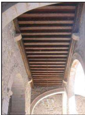
Imagen 115: Foto de la vigería de entrepisos de los corredores del primer patio. (Foto: José Antonio Morales A.)
