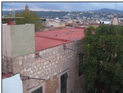
Imagen 55: panorámica, donde se observa la colocación de los tinacos en azotea. (Foto: José A. Morales A.)
