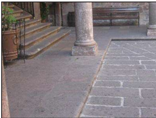
Imagen 49: de piso de piedra de cantería labrada en el área del primer patio. (Foto: José A. Morales A.)
