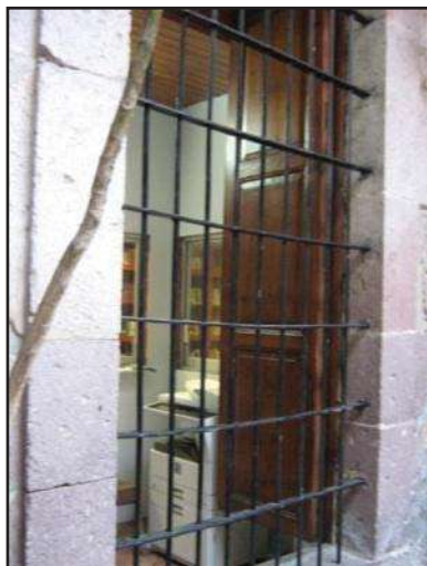
Imagen 66: interior, se observa las protecciones en ventanas fijadas al muro de cantería. (Foto: José A. Morales A.)
