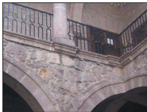
Imagen 69: panorámica del barandal en el corredor de planta alta, de hierro forjado. (Foto: José A. Morales A.)
