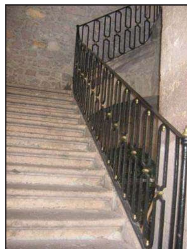
Imagen 131: Foto panorámica de la escalera principal, se observa el barandal adosado a los escalones, de hierro forjado. (Foto: José Antonio Morales A.)
