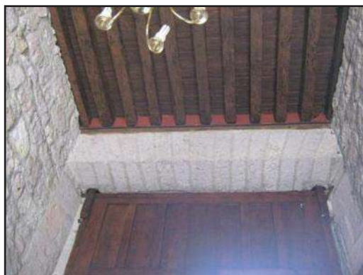
Imagen 45: de cerramiento interior de la puerta de acceso, platabanda dovelada, con capitalizado acabado aparente. (Foto: José A. Morales A.)
