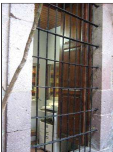
Imagen 130: Foto interior, se observa las protecciones en ventanas fijadas al muro de cantería. (Foto: José Antonio Morales A.)
