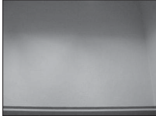
Imagen 40: de los Muros interiores de piedra de cantería, aplanados con mortero cal-arena. (Foto: José A. Morales A.)
