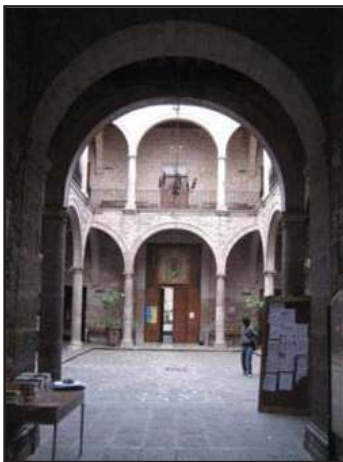
Imagen 94: Foto panorámica del primer patio tomada desde el acceso. Se observan los elementos neoclásicos (columnas de orden toscano y arcos de medio punto). (Foto José A. Morales A.)
