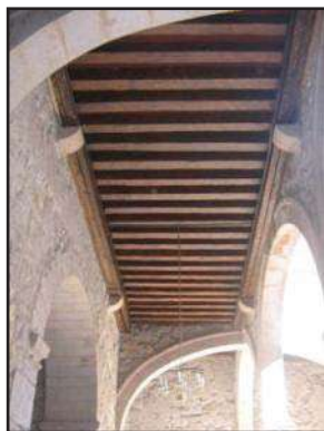
Imagen 51: de la viguería de entrepisos de los corredores del primer patio. (Foto: José A. Morales A.)
