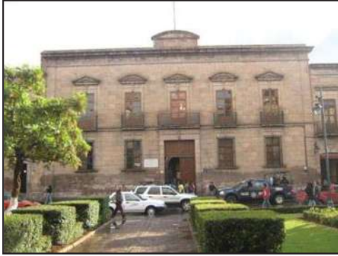
Imagen 27: panorámica de la fachada principal del inmueble, se denota la simetría de los elementos de estilo neoclásico (Foto: José A. Morales A.)
