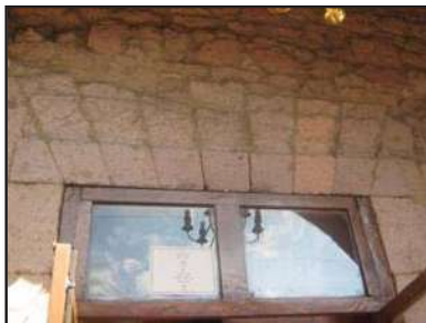
Imagen 31: del cerramiento en vanos, se observa la utilización de platabandas y clave dispuestas en forma concéntrica. (Foto: José A. Morales A.)
