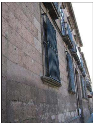
Imagen 129: Foto panorámica de la fachada principal, se observan las protecciones de hierro forjado adosadas al muro de cantería. (Foto: José Antonio Morales A.)
