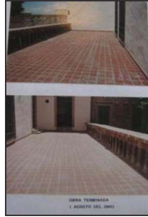
Imagen 4.- Foto del cambio de terrado y viguería del área de terraza del segundo patio. (Fuente: archivo del departamento de Patrimonio Universitario.)
