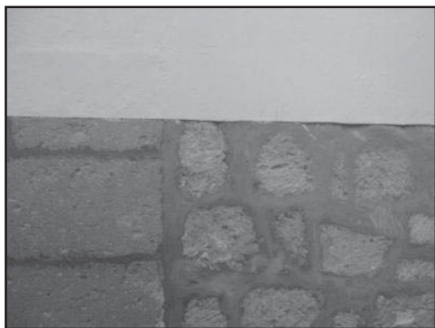
Imagen 172: Resane de juntas en mampostería con mortero de cemento. (Foto: José A. Morales A.)
