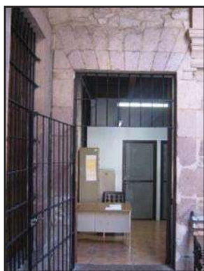
Imagen 107: Foto de cerramiento exterior en puerta, platabanda dovelada, con clave. (Foto: José Antonio Morales A.)
