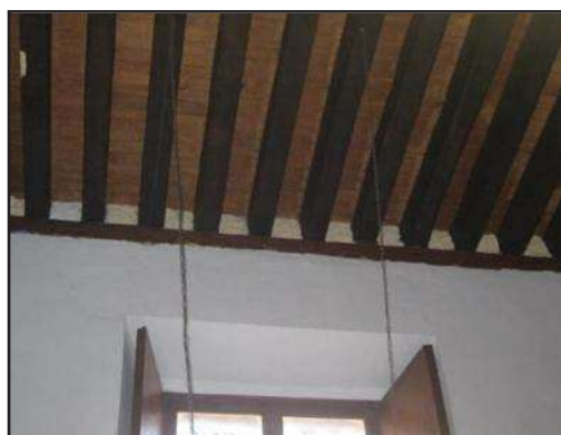
Imagen 108: Foto de cerramiento con capitalizado al interior, acabado con mortero cal-arena, pintura vinílica. (Foto: José Antonio Morales A.)
