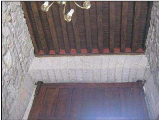
Imagen 109: Foto de cerramiento interior de la puerta de acceso, platabanda dovelada, con capitalizado acabado aparente. (Foto: José Antonio Morales A.)
