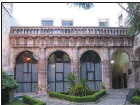
Imagen 162: Se cierra el corredor norte del segundo patio con cancelería de aluminio (Foto: José A. Morales A.)
