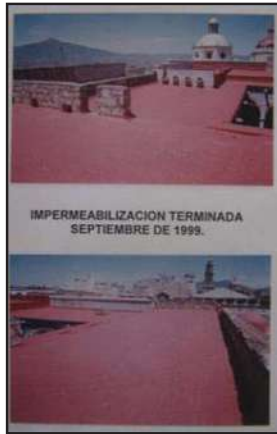
Imagen 1.- Foto de la impermeabilización en azotea (fuente: archivo del departamento de Patrimonio Universitario.)
