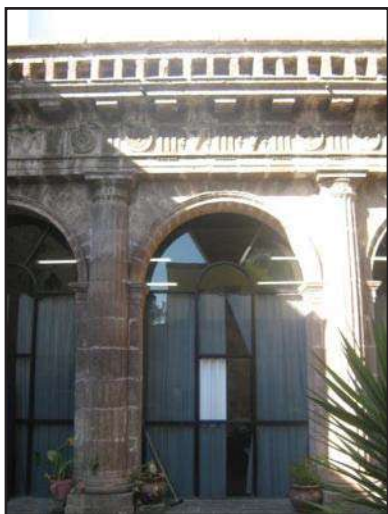
Imagen 134: Foto panorámica de la cancelaría de aluminio adosada a la arquería del corredor norte en el segundo patio. (Foto: José Antonio Morales A.)
