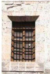
Fig.66 Protección de Fierro Forjado en Ventanas. Fuente: M. Arq. Ruggiero Zepeda Maldonado
