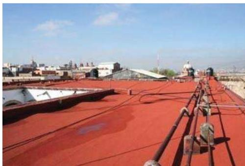
Fig. 18 Impermeabilizante laminar tipo SBS
