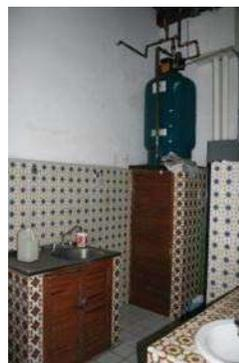
Fig. 56 Sistema hidroneumático en Baños
