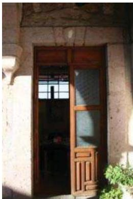
Fig. 48 Cerramiento interior platabanda
