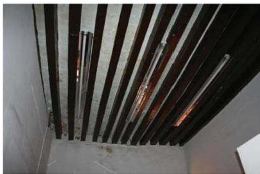
Fig. 17 Entrepiso y Losa de azotea a base de vigería de madera, tapa, terrado y/o mosaico o ladrillo.
