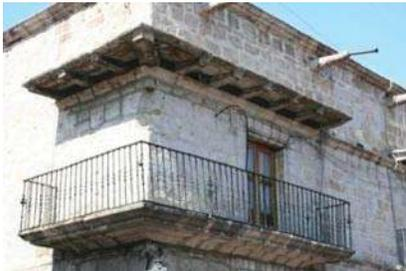
Fig. 65 Barandal en Balcón de Fierro Forjado. Fuente: M. Arq. Ruggiero Zepeda Maldonado.
