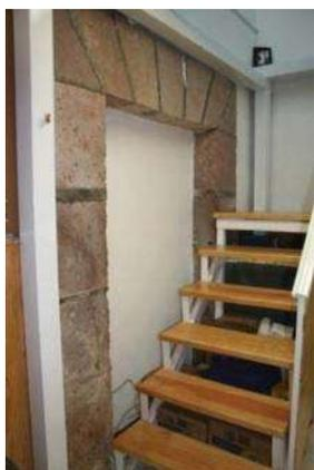
Fig. 44 Cerramiento interior a base de platabanda dovelada. Fuente: Foto M. Arq. Ruggiero Zepeda Maldonado
