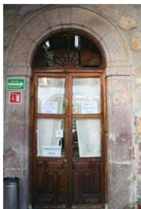
Fig. 45 Arcos de medio punto de piedra de cantería dovelada. Fuente: Foto M. Arq. Ruggiero Zepeda Maldonado
