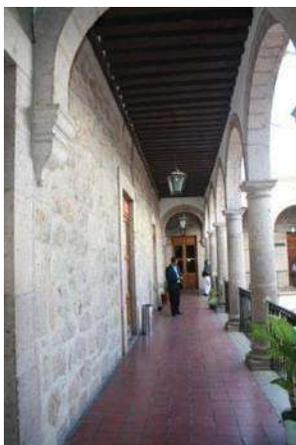
Fig. 50 Piso de cerámica en andadores de planta alta Fuente: Foto M. Arq. Ruggiero Zepeda M.
