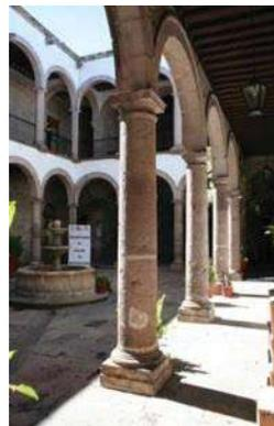
Fig. 49 Cerramientos en corredor, arcos de medio punto dovelado
