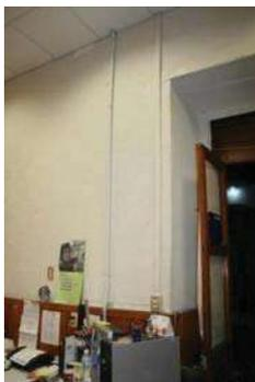
Fig. 59 Canalizaciones por muro para instalaciones a base de canaletas Fuente: Foto M. Arq. Ruggiero Zepeda Maldonado
