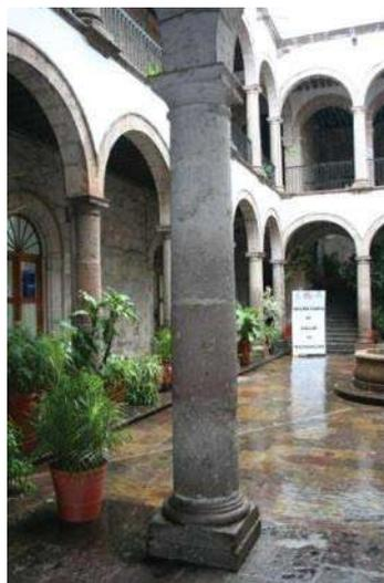
Fig. 14 Columna de Piedra de cantería en corredores Foto: Ruggiero Zepeda M.
