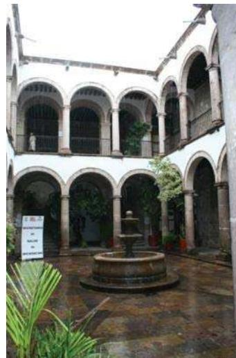
Fig. 13 Arcos de medio punto de cantería dovelada
