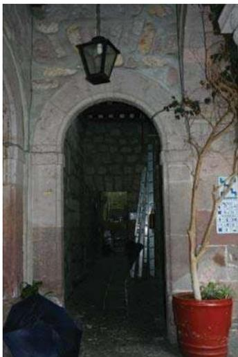
Fig. 11 Arco de cantería dovelada de medio punto en acceso a Oficinas en planta baja
