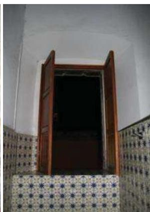
Fig. 46 Cerramiento interior capialzado. Fuente: Foto M. Arq. Ruggiero Zepeda Maldonado
