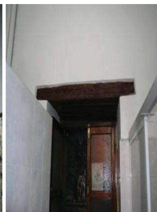
Fig. 47 Dintel de madera. Fuente: Foto M. Arq. Ruggiero Zepeda Maldonado
