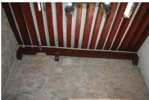
Fig. 53 Vigería de madera de pino 5"x8"Fuente: Foto M. Arq. Ruggiero Zepeda Maldonado
