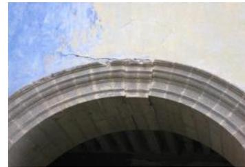
Figura 59 Asentamiento de dovelas en arco norte del nártex - foto tomada por el autor
