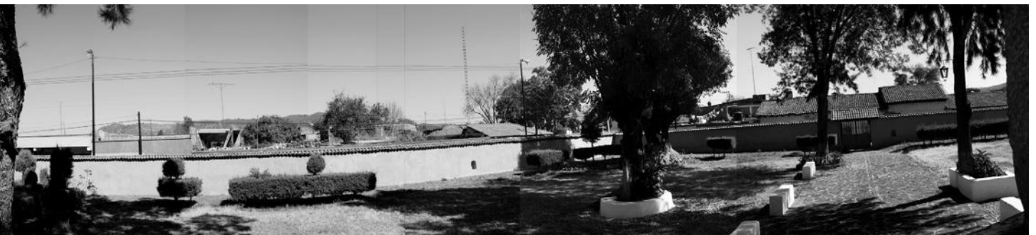
Imagen 17. Vista del atrio del conjunto religioso. Se observa los sanitarios y capillas posas.
