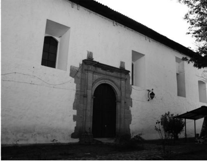
Imagen 36 y 37. Vista de fachada lateral y detalle de ventanas abocinadas.
