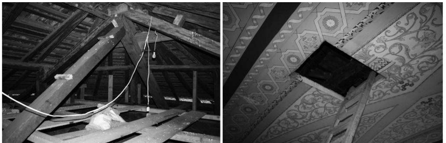
Imagen 52 y 53. Vista del estructura de madera y acceso a cubierta.
