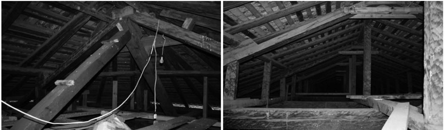
Imagen 64 y 65. Vista de vigería de madera en cubierta del templo.
