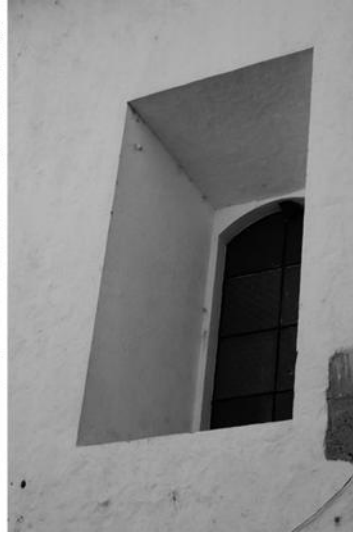
Imagen 36 y 37. Vista de fachada lateral y detalle de ventanas abocinadas.
