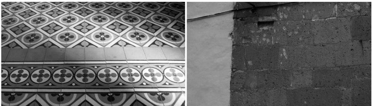
Imagen 62 y 63. Mosaico de Paste en Nave Principal y Cantería en Fachada Principal.
