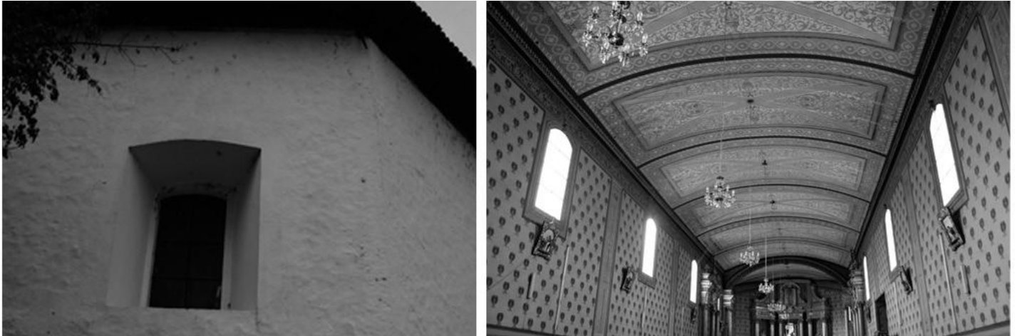
Imagen 55 y 56. Vano abocinado en el exterior e interior del Templo de Santiago Apóstol.
