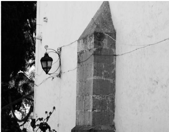
Imagen 34 y 35. Vista de contrafuerte en fachada norte y pináculos.
