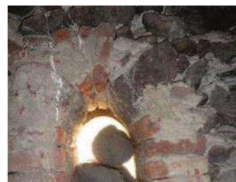
Figura 31. Cerramiento de arco de medio punto a base de ladrillo en el interior de la torre. Foto: MRBR.
