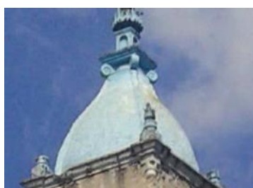
Figura 46. Cubierta de la torre. Foto: MRBR.
