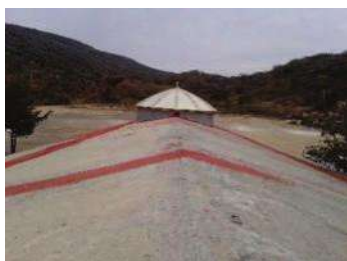
Figura 26. Cubierta de concreto de la capilla. Foto: MRBR.
