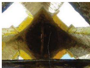
Figura 49. Cerramientos curvos en segundo cuerpo de la torre. Foto: MRBR.
