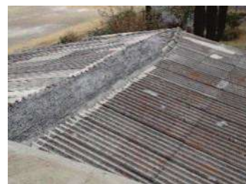
Figura 28. Cubierta de teja prefabricada de asbesto y fibra de vidrio. Foto: MRBR.
