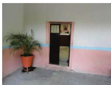
Figura 52. Piso en exterior de sacristía. Foto: MRBR.
