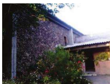
Figura 42. Contrafuertes de concreto agregados para sostener la cubierta. Foto: MRBR.
