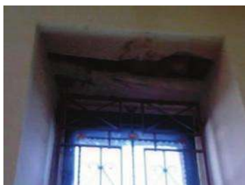
Figura 48. Cerramiento de vano de ventana en nave. Foto: MRBR.
