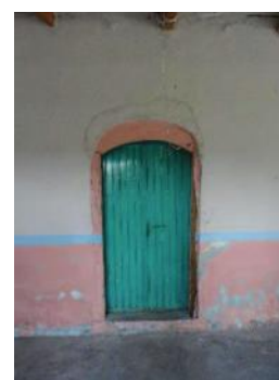
Figura 25. Vano de acceso a bodega. Foto: MRBR.
