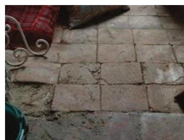
Figura 53. Piso en bodega. Foto: MRBR.
