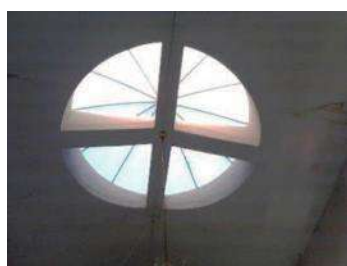
Figura 45. Cubierta de la nave. Foto: MRBR.
