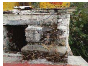
Figura 56. Presencia de microflora y macroflora en torre. Foto: MRBR.
