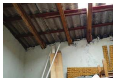
Figura 47. Cubierta de la sacristía. Foto: MRBR.
