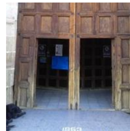
Ilustración 46. Piso en acceso
