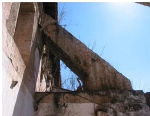
Ilustración 66. Area de contrafuertes. Vista desde anexo. Fuente: Fotografía del autor. 2012
