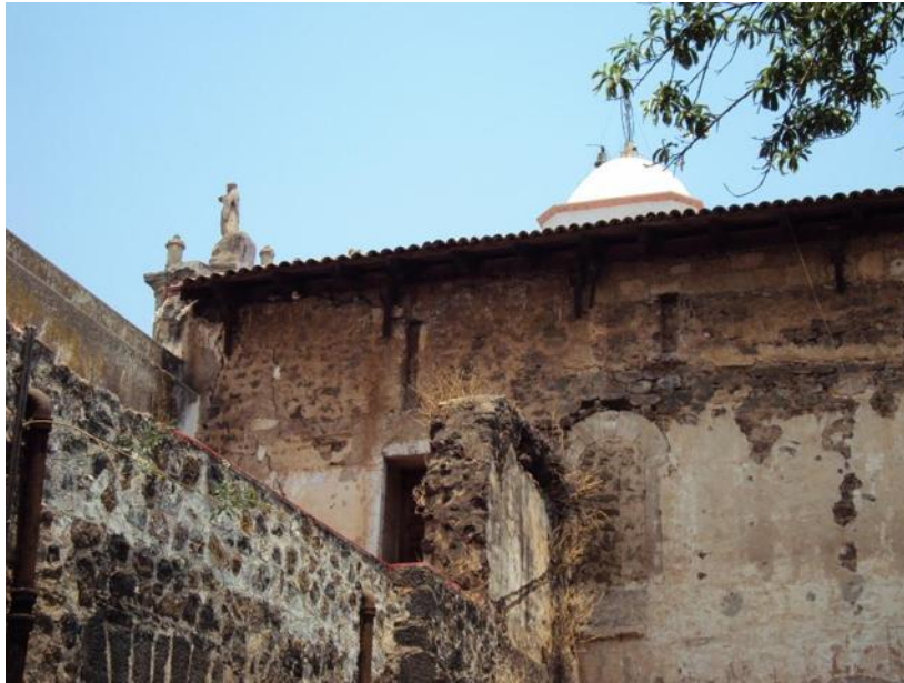
Ilustración 55. Vista de acceso a coro. Muro sur, desde anexo. Fuente: Fotografía del autor. 2012
