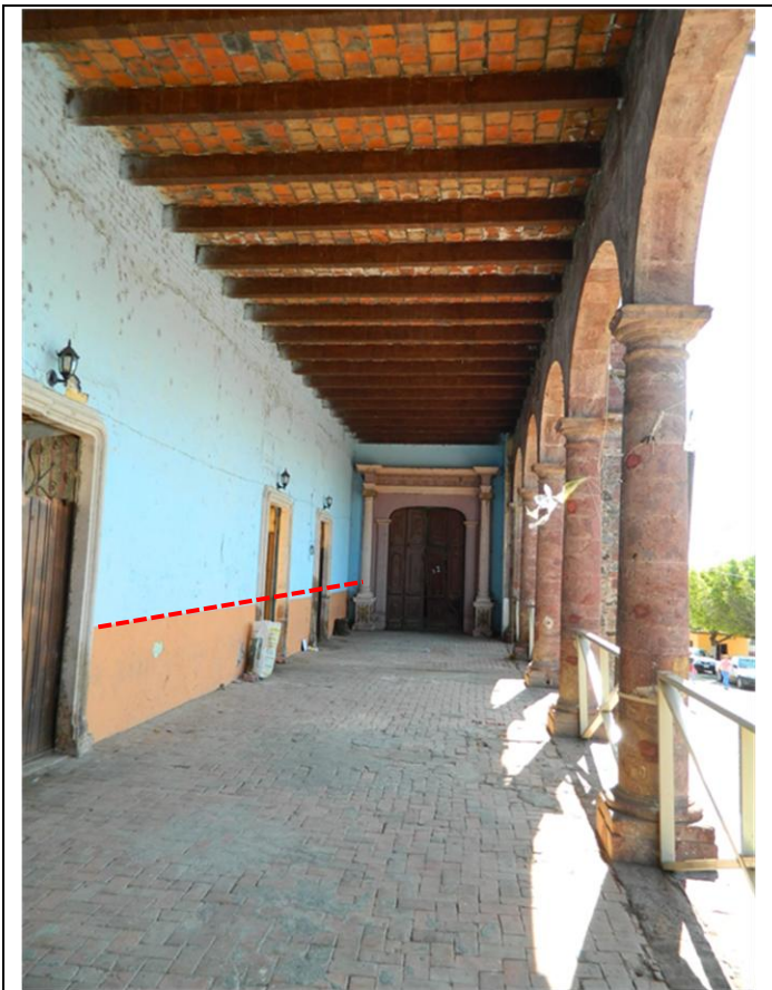
Imagen 060.- Fotografía que muestra la línea imaginaria sobre las marcas de nivel para guía de medición. Espacio: Pórtico.
