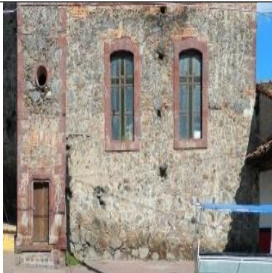
Imagen 154.- Muestra de aparejo de mampostería de piedra irregular empleado en la capilla.
