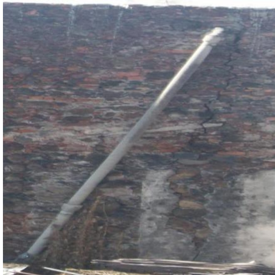
Imagen 204.- Colocación de bajante de asbesto para el desalojo del agua pluvial de la cubierta de la capilla.
