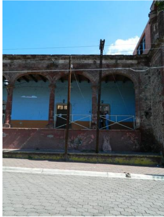
Imagen 071.- Fotografía del levantamiento de mediciones en
