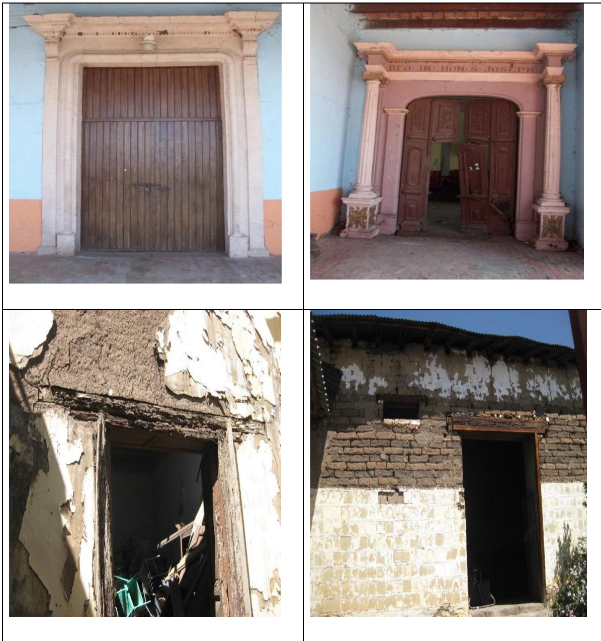
Imagen 265.- Vista de los enmarcamientos y dinteles.
