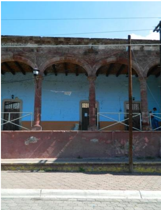
Imagen 072.- Fotografía del levantamiento de mediciones en fachada.
