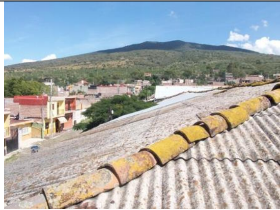
Imagen 180.- Cubierta de madera con lámina de asbesto, inclinada a dos aguas.
