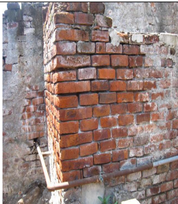
Imagen 131.- Apreciación de muro de ladrillo recocado.
