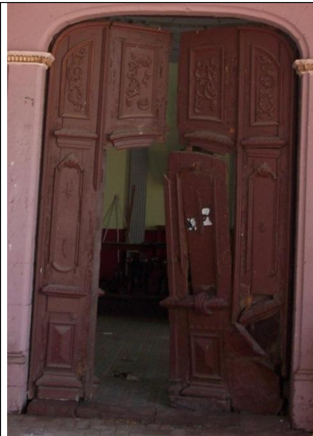
Imagen 214.- Vista de la puerta de madera en el acceso a la capilla.
