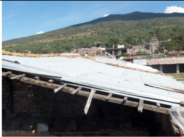
Imagen 179.- Vista de la cubierta de madera y teja de barro, inclinada a dos aguas.
