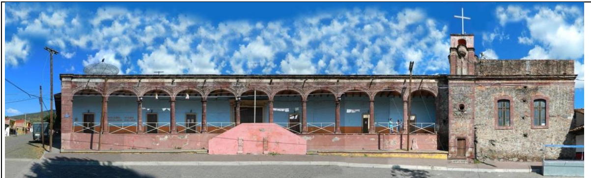
Imagen 092 .- Vista exterior de la fachada poniente.
