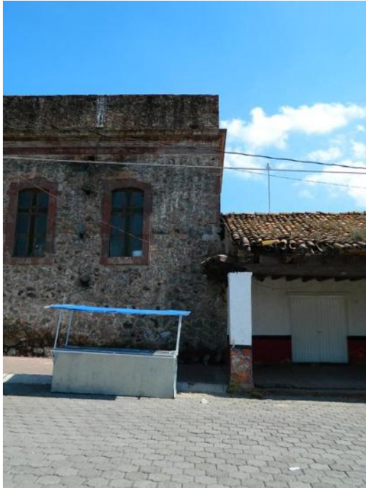
Imagen 066.- Fotografía del levantamiento de mediciones en fachada.
