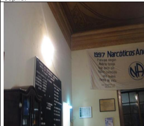
Imagen 208.- Vista de lámpara incandescente sobre muro.
