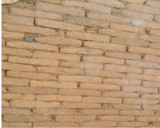
Imagen 190.- Vista de muro de adobe.
