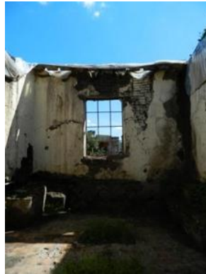
Imagen 054.- Vista interior de la Cocina sistema de ventilación.
