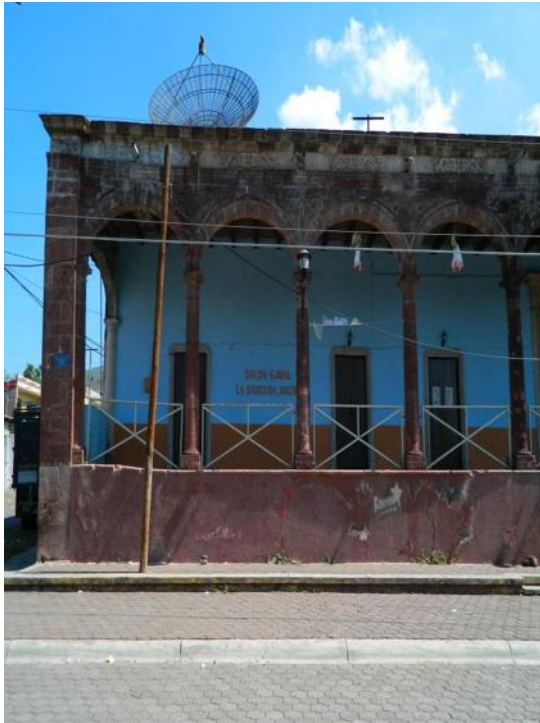
Imagen 078.- Fotografía del levantamiento de mediciones en fachada.
