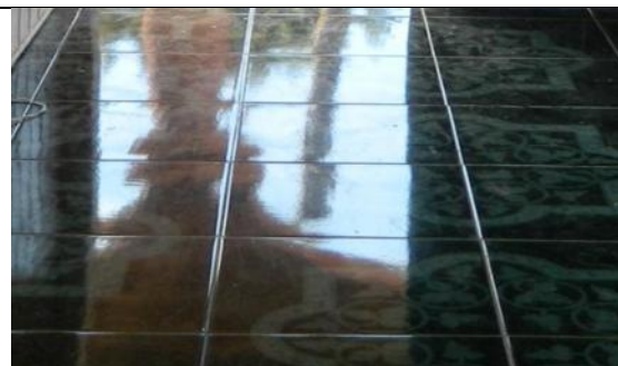
Imagen 195.- colocación de piso de cerámica en el área del salón ejidal.
