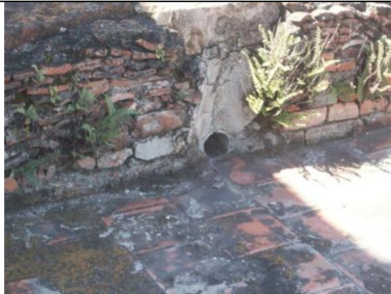
Imagen 202.- Vista de desgüe por medio de gárgola ubicada en la azotea del pórtico.
