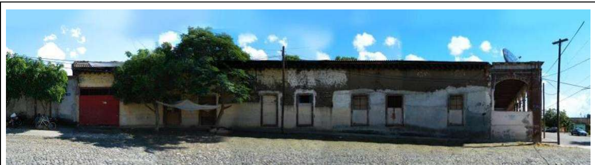
Imagen 081.- Conformación de la unión de fotografías tomadas en situ, para formalizar la fotografía general de la fachada lateral de la casa grande, ex hacienda de la Saucedá, Zamora, Michoacán.
