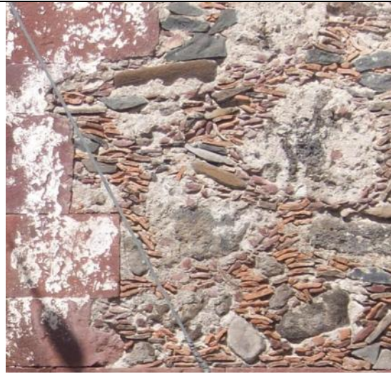
Imagen 250.- Vista de la cimentación.
