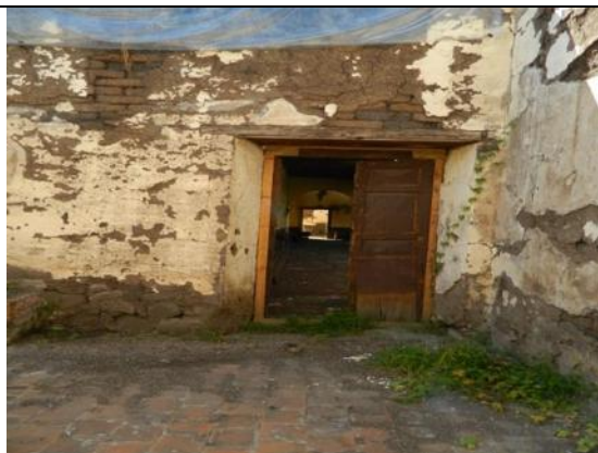
Imagen 251.- Vista de los muros y aplanados.
