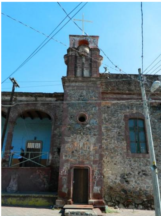
Imagen 068.-Fotografía del levantamiento de mediciones en fachada.
