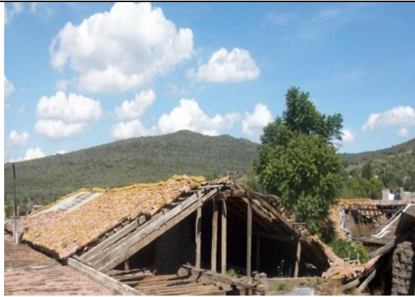
Imagen 179.- Vista de la cubierta de madera y teja de barro, inclinada a dos aguas.
