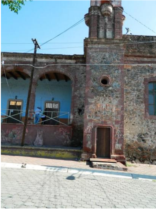
Imagen070.- Fotografía del levantamiento de mediciones en
