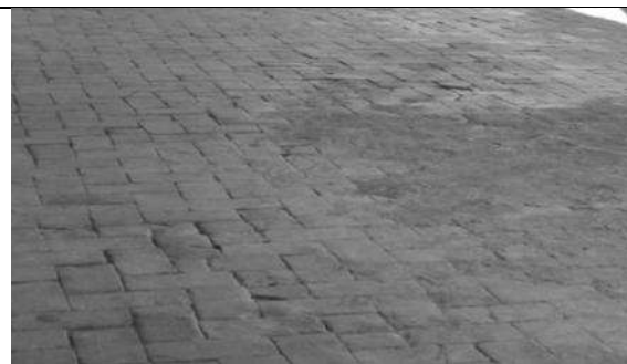
Imagen 194 .- Vista de la colocación de piso de barro en el portal de la fachada principal.
