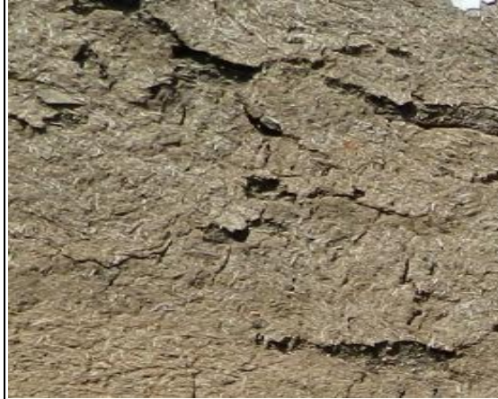
Imagen 191 .- Muestra de muro con aplanado de adobe
