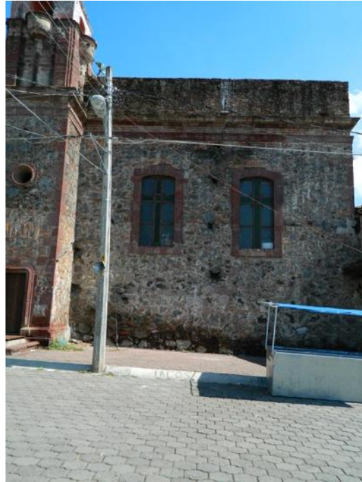
Imagen 067 -. Fotografía del levantamiento de mediciones en fachada.
