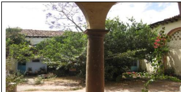
Imagen 158.- Columna ubicada en el patio central.
