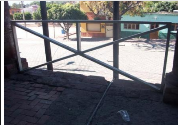
Imagen 216.- Vista del barandal de herrería tubular en el pórtico de la fachada principal.
