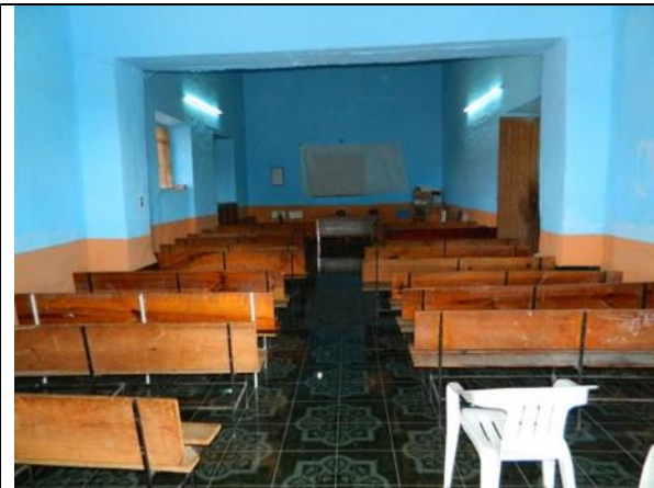
Imagen 240.- Vista del interior del salón ejidal.
