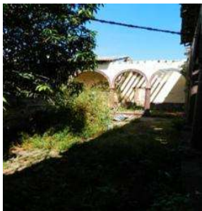
Imagen 056 .- Vista interior del patio central.
