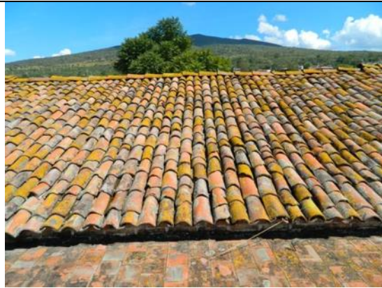
Imagen 203 .- Vista de la cubierta de teja como medio de desgüe pluvial hacia patio central y sobre azotea de pórtico principal.
