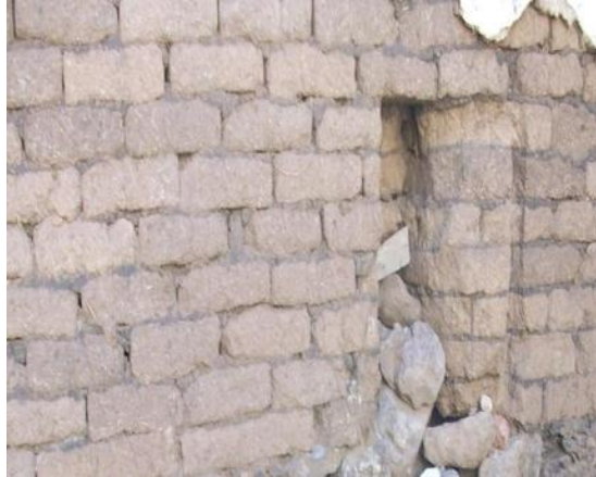
Imagen 153.- Muestra de aparejo de adobe empleado en este inmueble.
