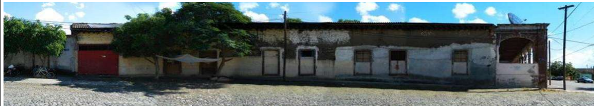
Imagen 093 .- Vista exterior de la fachada norte.
