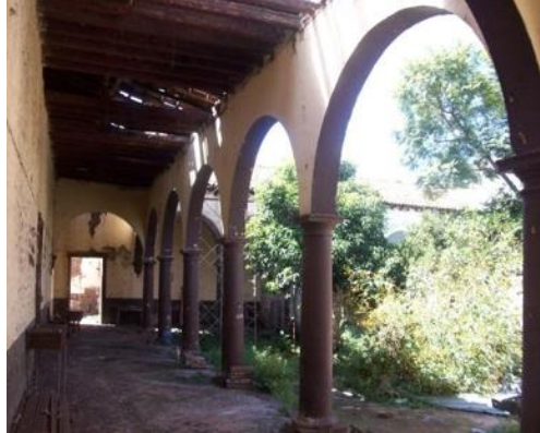
Imagen 165.- Vista de los arcos de medio punto en el corredor sur del interior del patio central.
