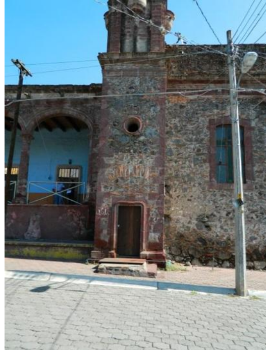
Imagen 069.- Fotografía del levantamiento de mediciones en fachada.
