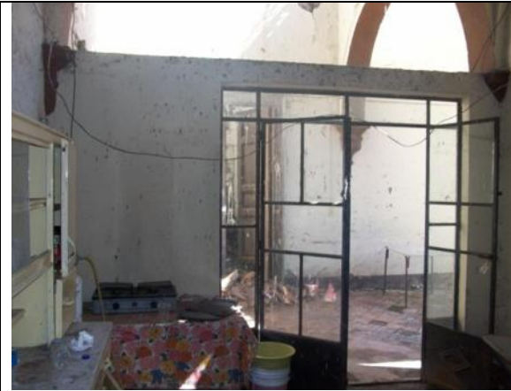
Imagen 210- Instalación de gas con tanque móvil.
