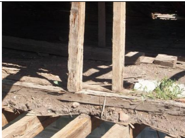
Imagen 183.- Vista del entrepiso donde se percibe la vigería, tejamanil y el terrado de adobe, sobre el área que corresponde a la sala.
