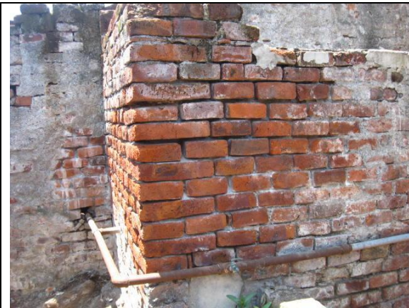
Imagen 200- Imagen de la tubería de la instalación hidráulica.
