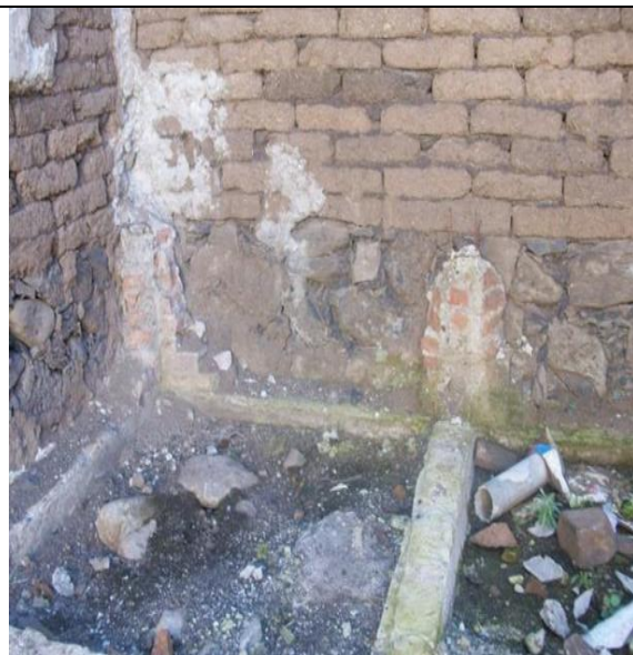
Imagen 129.- Vista interior de muro de adobe.
