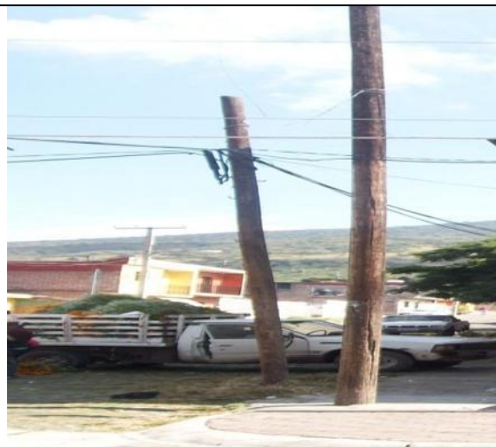
Imagen 213.- Equipamiento de infraestructura para el tendido de redes.
