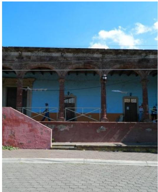
Imagen 073.- Fotografía del levantamiento de mediciones en fachada.
