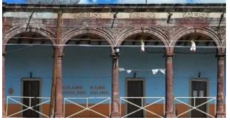
Imagen 166 .- Vista principal de la arcada de la fachada poniente construidos a base de cantería.
