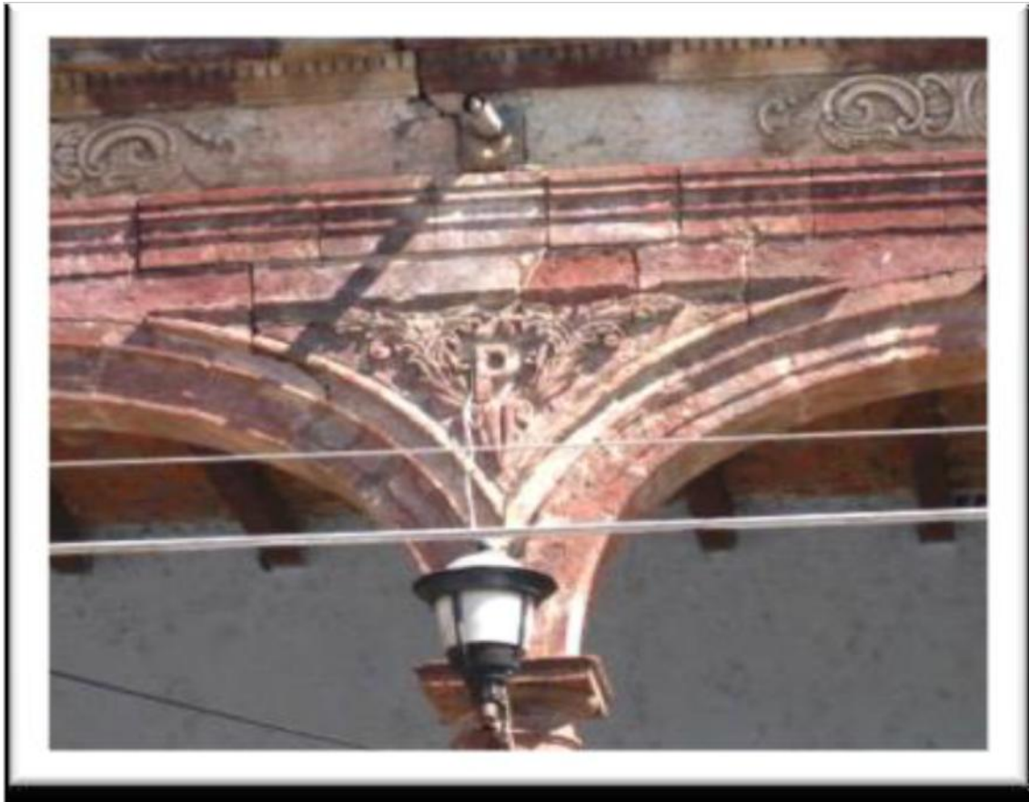
Imagen 086 .- Vista de la cantería grabada en alto relieve en la enjuta de la arquería en la fachada principal.
