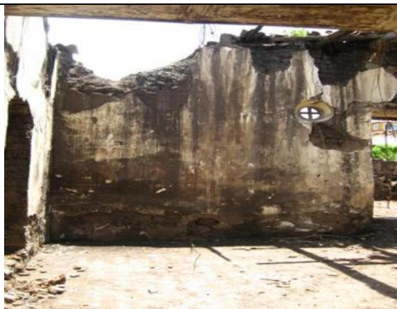
Imagen 252.- Vista de los muros y aplanados.
