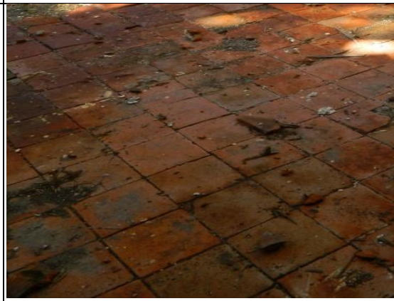
Imagen 193.- colocación de piso de baldosa de sección de 20x20cms.
