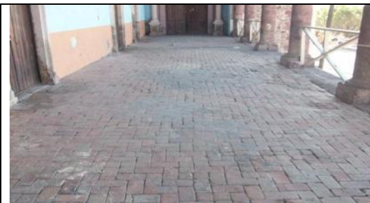
Imagen 147.- muestra del piso de tabique de barro en el pórtico de la fachada principal.
