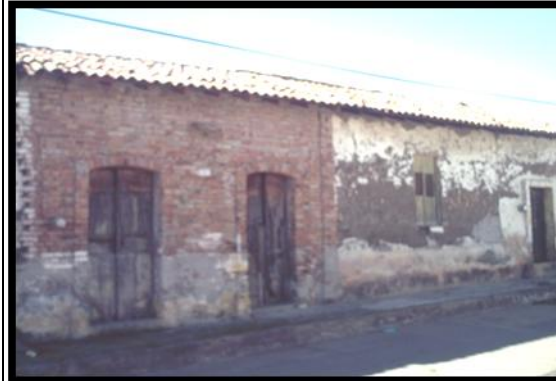
Imagen 118.- Casa ubicada en la calle unión esq. Portugal.
