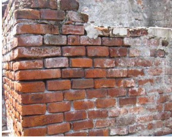
Imagen 152.- Muestra de aparejo de ladrillo de barro recocido.
