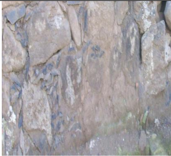
Imagen 249.- Vista de la cimentación.
