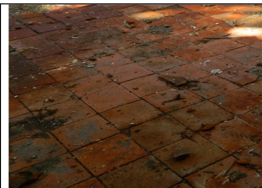
Imagen 149.- Vista del piso de baldosa de barro en patio y corredores.
