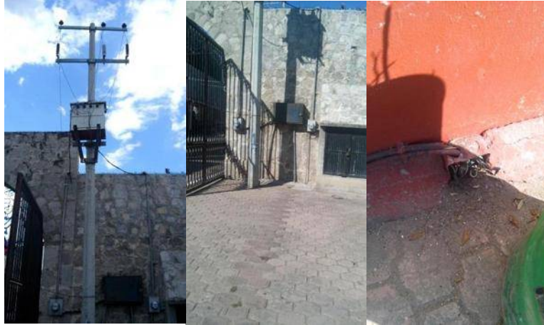
Imagen # 33 Suministro de instalación eléctrica Fotografía: Andrés García Torres
