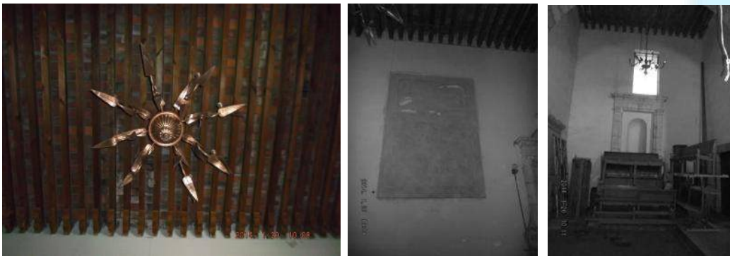
Imagen #32 Instalación eléctrica visible en el inmueble.
