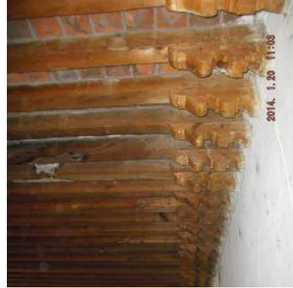
Imagen # 30 Vigería de madera con zapatas
