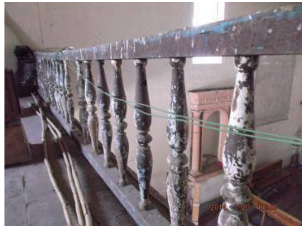
Imagen # 31 Balaustrada del coro
