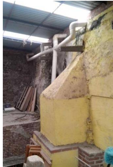
Imagen #75 Contrafuerte, losa y bajadas de agua pluvial
