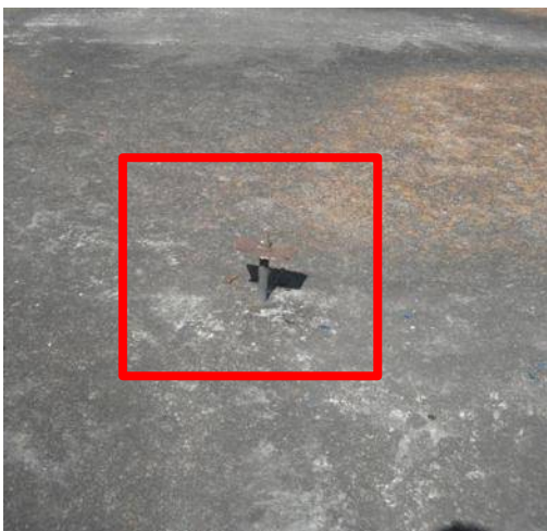
Imagen #95 Perforación de losa; para soportar los candelabros Andrés García Torres
