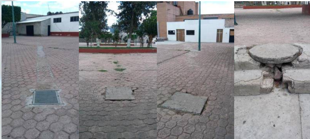
Imagen # 36 Instalación de aguas pluviales y sanitaria Fotografía: Andrés García Torres
