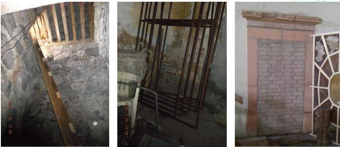
Imagen #24 Muros de la torre a base de mampostería de piedra, muros del bautisterio a base de tabique y vano tapeado que da al anexo del templo.
