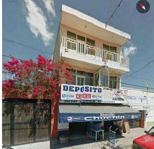
Imagen #12 Vivienda con sistema constructivo de tabique y concreto armado
