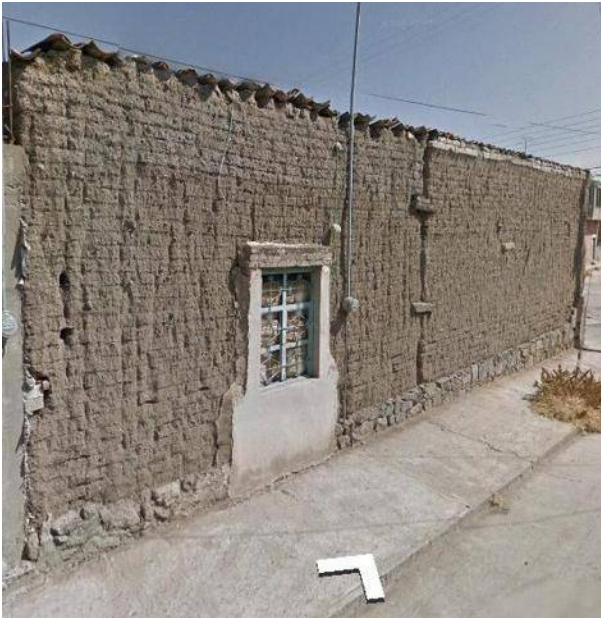
Imagen #10 Vivienda tradicional con sistema constructivo de tejas y adobe Google maps
