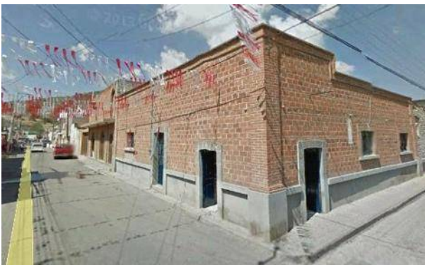
Imagen #11 Vivienda con sistema constructivo de tejas y tabique aparente Google maps
