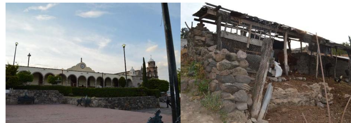
Foto 37. Vista del área construida-EXIST. MCHB. 23/12/14.
