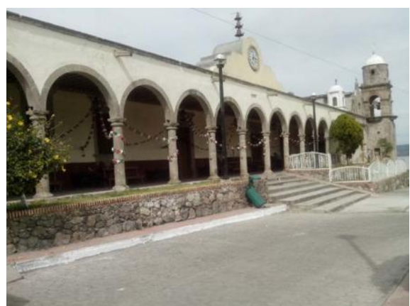
Foto.35. Vista de la fachada este. MCHB 24/12/2014.
