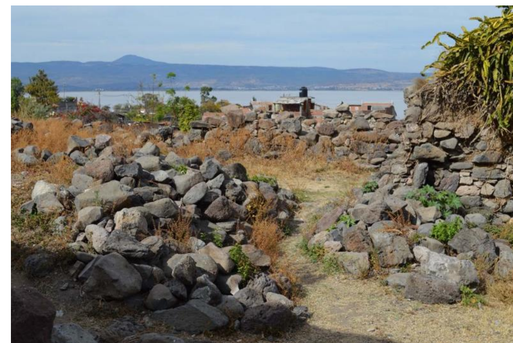
Foto 43. Estado actual de parte en ruinas del casco de la ex hacienda de Santa Rita. MCHB. 23/12/14.
