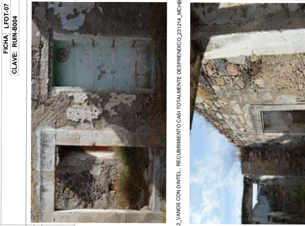
FO14_RESTOS DE AFUNADOS SOBRE MURO DE PIEDRA IRREGULAR_231214_MCHB
