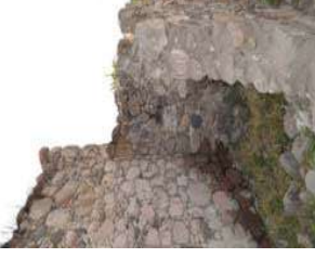
F21_MURO DE PIEDRA IRREGULAR, SE OBSERVA QUE LAS PIEDRAS FUERON JUNTEADAS CON TIERRA _231214_MCHB
