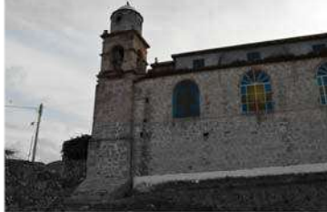
VISTAS DE LA FACHADA NORTE
