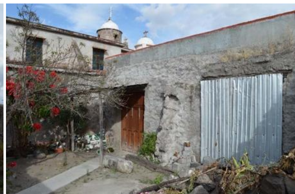
Foto. 34. Vista de la fachada sur. MCHB 24/12/2014.
