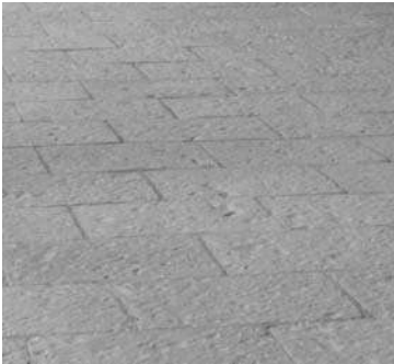
Piso en arcada
