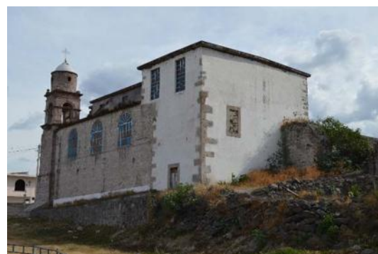
Foto 24. En esta parte de la fachada sur de la capilla era donde estaba el mirador. MCHB.01/02/15.
