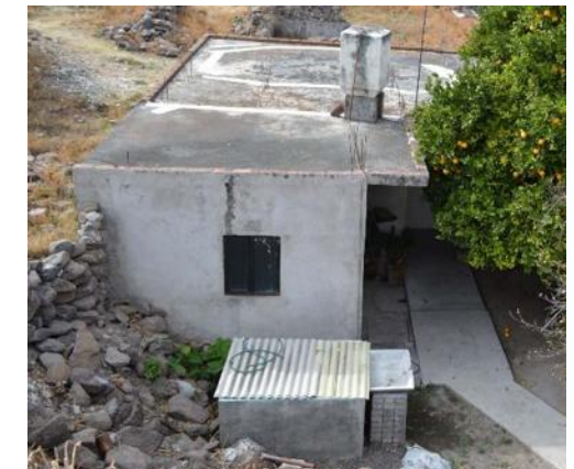
Foto 42. Vista del módulo localizado en el área PROVC-001 de la Sacristía. MCHB. 22/12/14.
