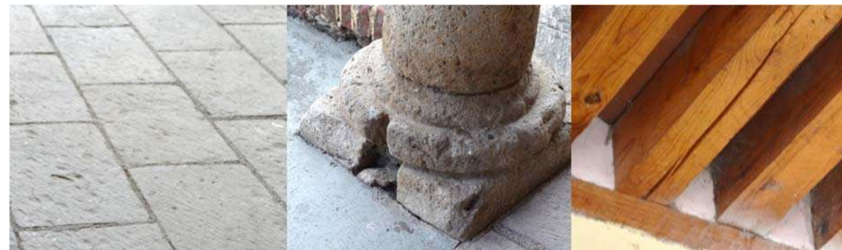
Foto. 46. Piso en buen estado. MCHB. 23/12/14.
