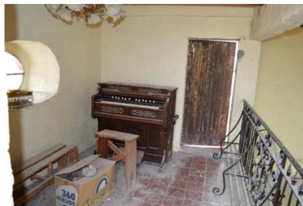
Foto 64. Vista general del coro. MCHB. 23/12/14.
