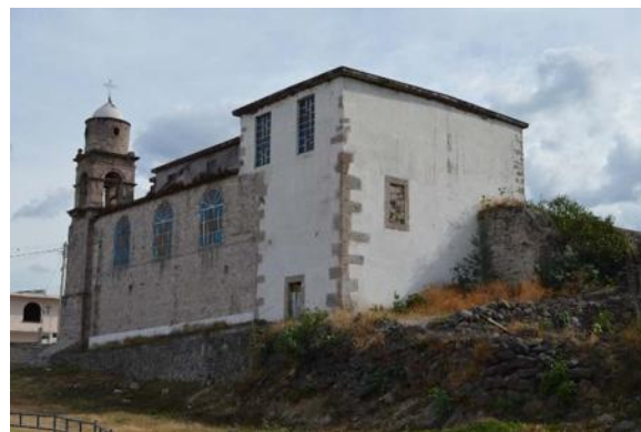
Foto. 33. Vista de la fachada Norte. MCHB 24/12/2014.
