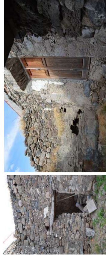
F15_VISTA DE VANO EXISTENTE, CON CERRAMIENTO DE PIEDRA Y MADERA. _231214_MCHB
