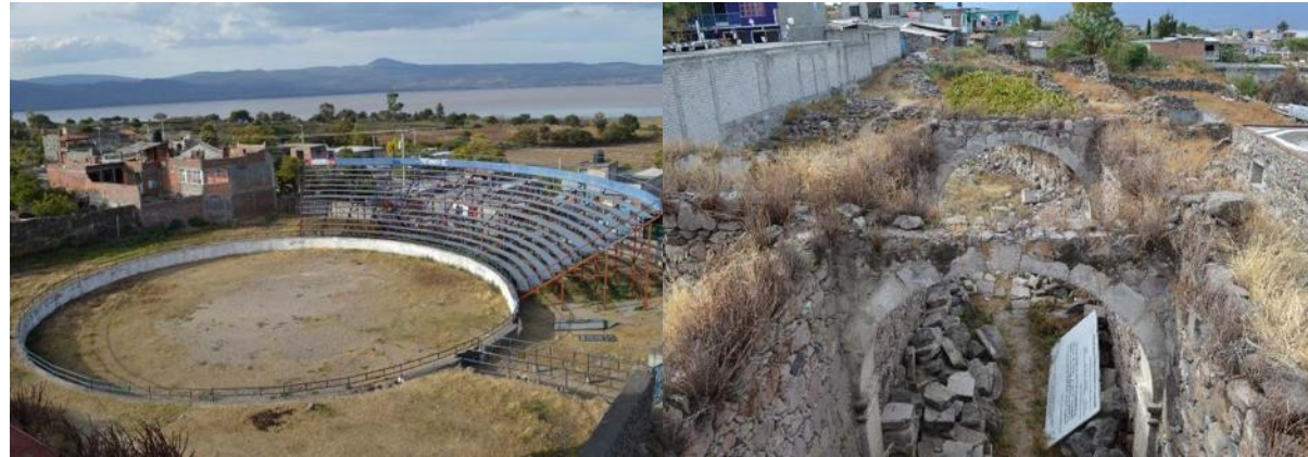
Foto 39. Vista del área provisional –PROV. MCHB. 23/12/14. Foto 40. Vista del área en estado de ruina –RUIN. MCHB. 23/12/14.
