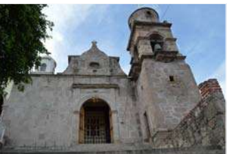
VISTAS DE LA FACHADA ESTE
