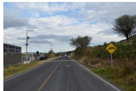
Foto 03. Vista de la carretera de acceso a la comunidad.MCHB.01/02/15.
