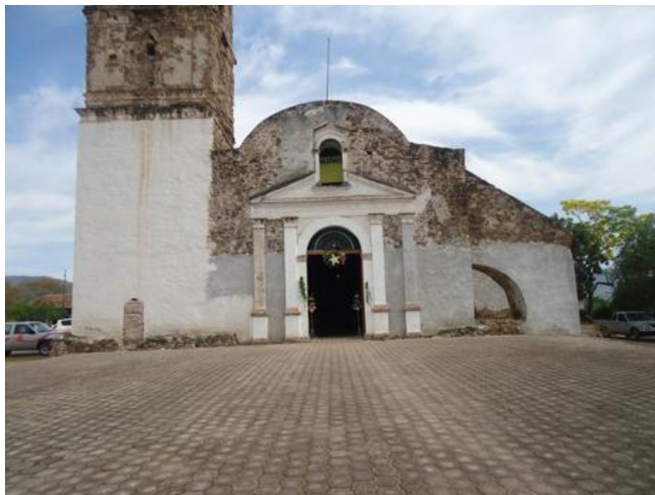
Fig. 5.16 Aplanados existentes e integración de nuevos aplanados Fuente: Hugo Angel Orozco Santibáñez
