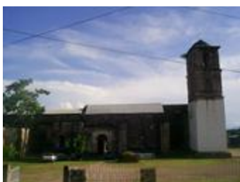
Foto ext. 17 Fachada norte Fuente: Hugo Angel Orozco Santibáñez
