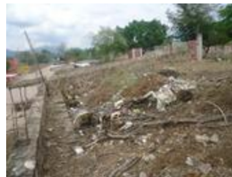
Foto ext. 33 Relleno de plataforma acceso principal Fuente: Hugo Angel Orozco Santibáñez
