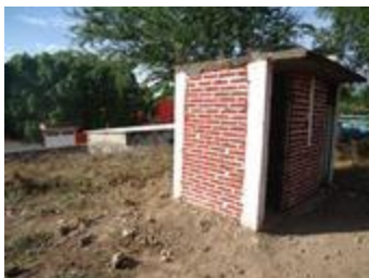
Foto ext. 5 Atrio-sanitarios Fuente: Hugo Angel Orozco Santibáñez
