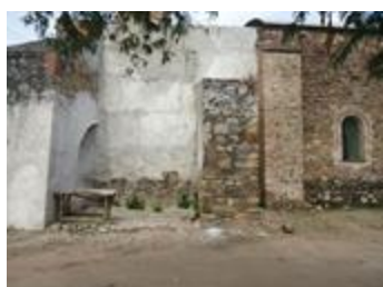
Foto ext. 28 Arbotantes muro sur Fuente: Hugo Angel Orozco Santibáñez
