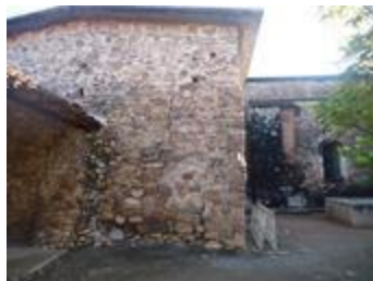
Foto ext. 13 Apoyos de capilla Fuente: Hugo Angel Orozco Santibáñez
