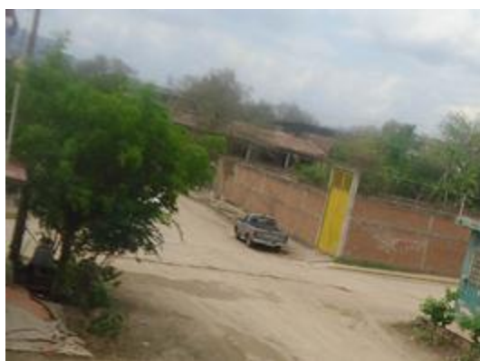
Fig. 3.18 Calle Santa Isabel con pavimento Fuente: Hugo Angel Orozco Santibáñez
