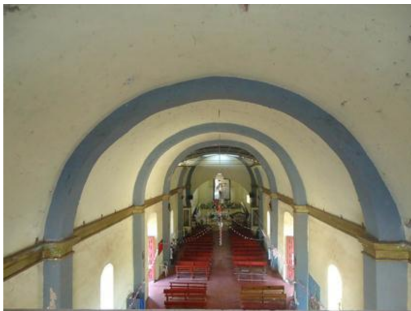
Fig. 7.10. Diferencia de luz y flecha en los arcos fajones Foto: Hugo Angel Orozco Santibáñez
