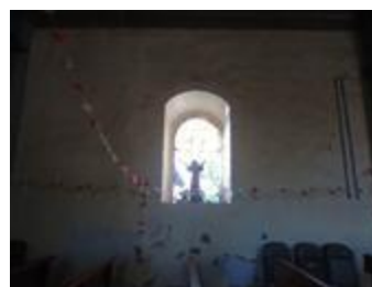
Foto int. 24 Vano de ventana Fuente: Hugo Angel Orozco Santibáñez
