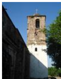
Foto ext. 10 Torre campanario Fuente: Hugo Angel Orozco Santibáñez
