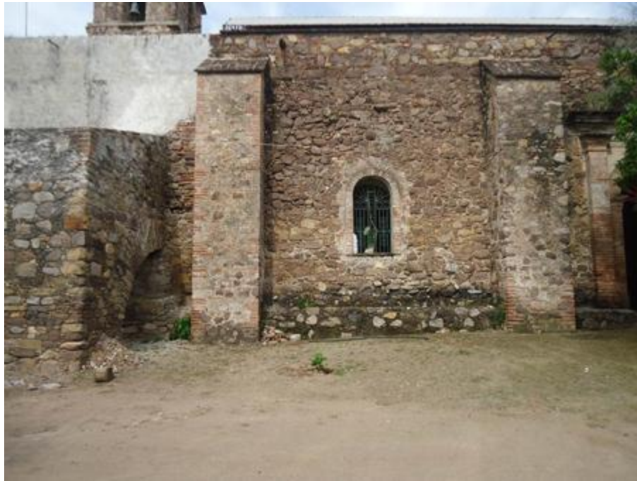
Fig. 5.15 Textura de muro, contrafuertes y arbotante Fuente: Hugo Angel Orozco Santibáñez
