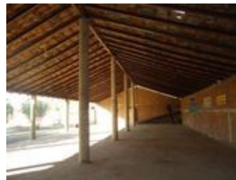
Foto ext. 15 Interior del salón parroquial Fuente: Hugo Angel Orozco Santibáñez
