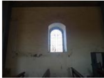
Foto int. 5 Vano de ventana Fuente: Hugo Angel Orozco Santibáñez
