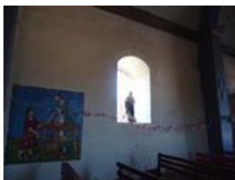
Foto int. 29 Vano de ventana Fuente: Hugo Angel Orozco Santibáñez
