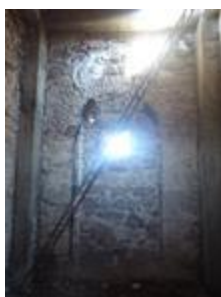
Foto int. 40 Vano tapiado en el primer cuerpo del campanario Fuente: Hugo Angel Orozco Santibáñez
