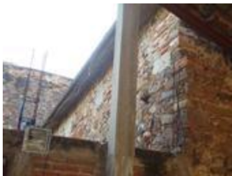
Foto ext. 14 Apoyo y cadena de ángulo de capilla Fuente: Hugo Angel Orozco Santibáñez
