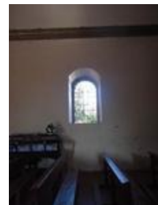
Foto int. 9 Vano de ventana Fuente: Hugo Angel Orozco Santibáñez
