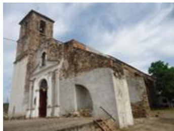
Foto ext. 31 Arbotantes muro sur Fuente: Hugo Angel Orozco Santibáñez
