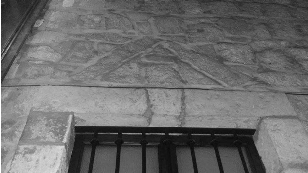
Imagen 38 Vista de un arco de descarga triangular Fuente: Fotografía del autor.
