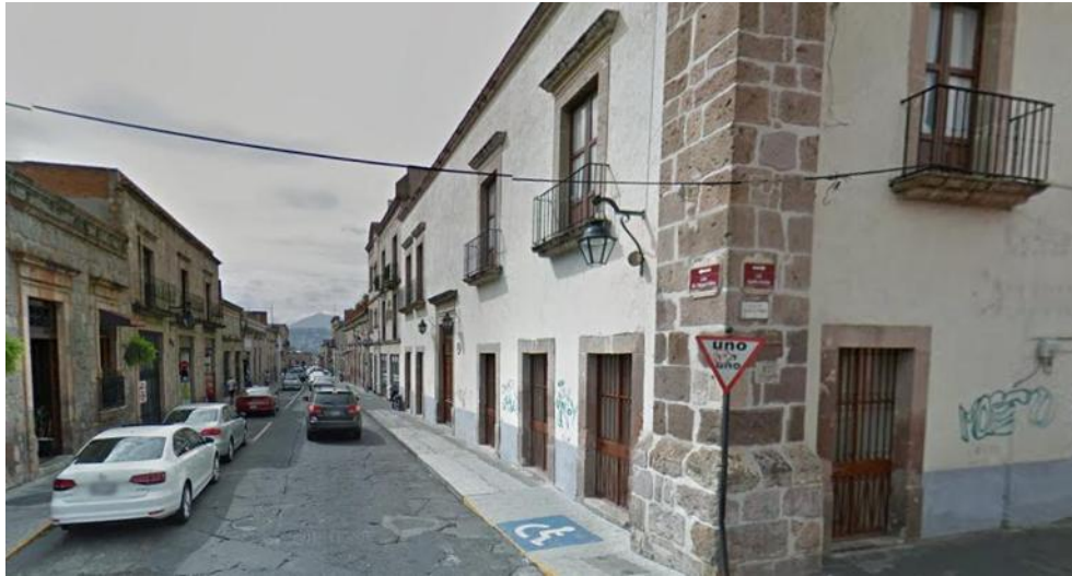
Imagen 9 Vista de los edificios contiguos, sus perfiles y sistemas constructivos Fuente: fotografía tomada de google maps..
