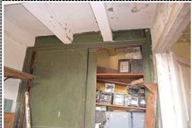
2. VISTA DE RECÁMARA EN PLANTA ALTA.
