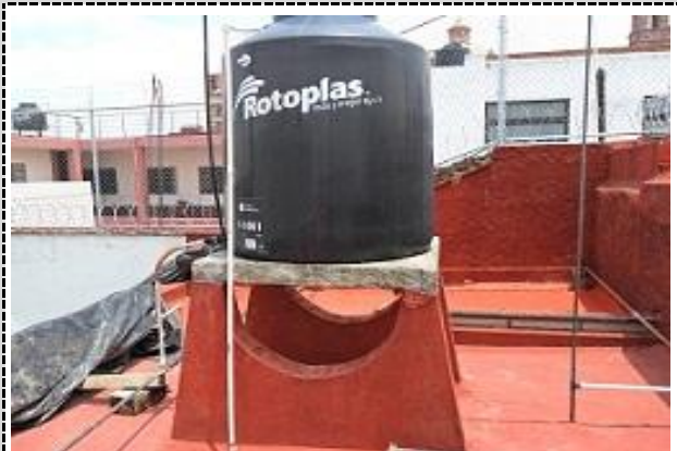
4. VISTA DE AZOTEA, SOBRE COCINA.
