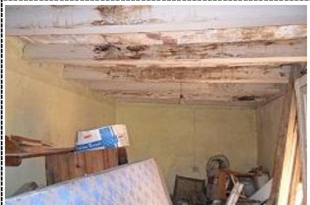
4. VISTA DE LA HANITACIÓN INFERIOR EN SEGUNDO PATIO.
