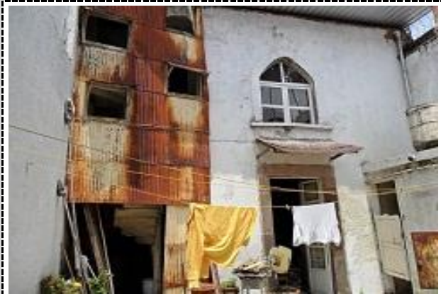
2. VISTA A HABITACIONES EN SEGUNDO PATIO.
