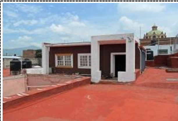
3. VISTA DE AZOTEA.
