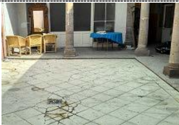
3. VISTA DEL PATIO DESDE EL ACCESO.
