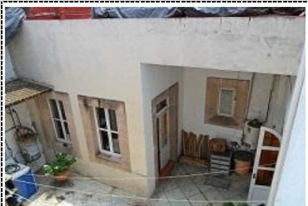
4. VISTA DEL ACCESO AL SEGUNDO PATIO.
