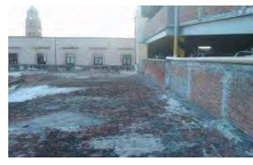
IMAGEN: 400 En el área vestíbulo, se colocó concreto en sustitución de relleno de y ladrillo de la vigería.
