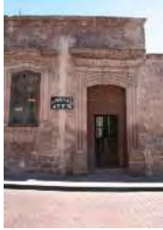
IMAGEN: 025 Vista del acceso a la vivienda a través del portón.
