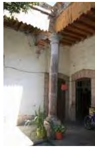
IMAGEN: 031 Columna de apoyo cubierta de los corredores del patio principal
