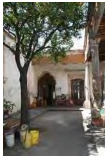
IMAGEN: 075 Asolamiento en sur – poniente en el patio del principal 18/01/2011 01. 31 pm
