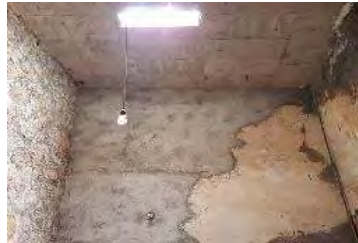
IMAGEN: 397 Sustitución de la vigería y colocación de losa de concreto armado en la cocina-comedor.
