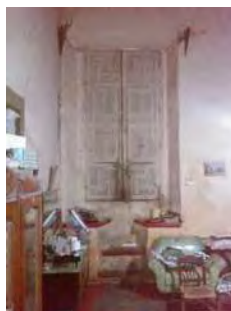
IMAGEN: 096 Ventana con capialzado y derrames de los muros en la sala - estudio,
