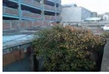
IMAGEN: 399 En el área del corredor lado sur, la colocación concreta en sustitución de relleno de y ladrillo de la vigería.
