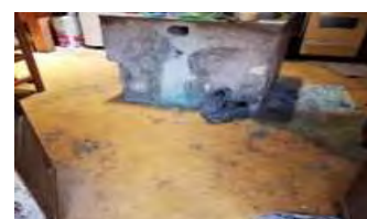
IMAGEN: 050 Piso de la cocina (2) firme de concreto y pintura.
