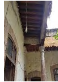
IMAGEN: 035 Sustitución de gualdras por vigas de concreto
