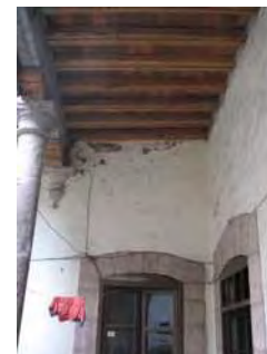
IMAGEN: 380 Viga y losa de concreto del muro este del patio principal.
