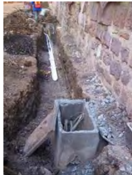
IMAGEN: 101 Vista de la cepa durante la colocación de aerodrén.
