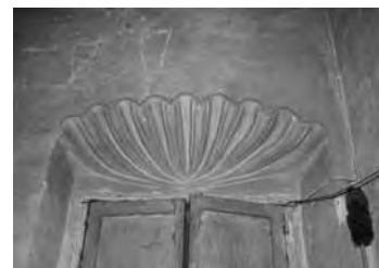
IMAGEN: 095 Capialzado de puerta de cocina - comedor que representa una concha mar.
