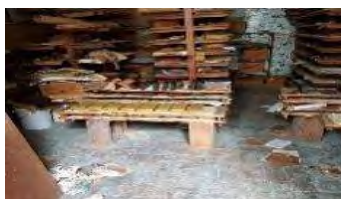
IMAGEN: 048 Piso loseta de barro del almacén de ates.
