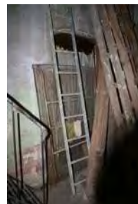
IMAGEN: 067 Puerta clausurada queda acceso al vestibulo
