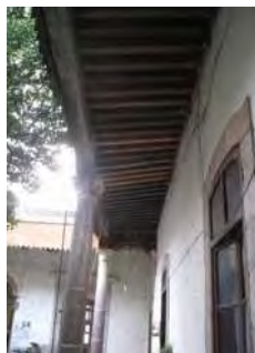
IMAGEN: 379 Viga y losa de concreto en el muro oeste sur del patio principal.
