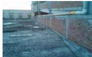
IMAGEN: 402 Colocación de losa de concreto en sustitución de la cubierta de enladrillado de la vigería.
