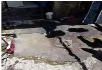
IMAGEN: 051 Piso del patio secundario de la vivienda.
