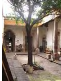
IMAGEN: 019 Fotografía vista del patio lado sur - poniente del inmueble la Providencia de los Ates
