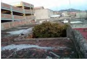
IMAGEN: 398 En el área del corredor lado oeste, la colocación concreto en sustitución de relleno de y ladrillo de la vigería.
