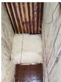
IMAGEN: 060 Cables de la instalación eléctrica en los muros del zaguán
