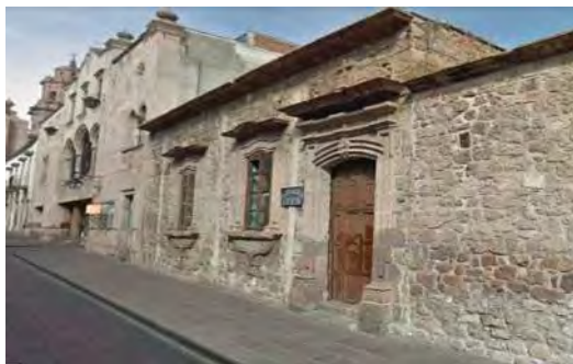
IMAGEN: 001 Vista de la fachada de la vivienda desde la calle de García Obeso
