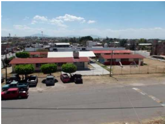
Fig.48 Escuela primaria localizada sobre la calle Juárez. Fuente: Fotografía Actual tomada por el autor
