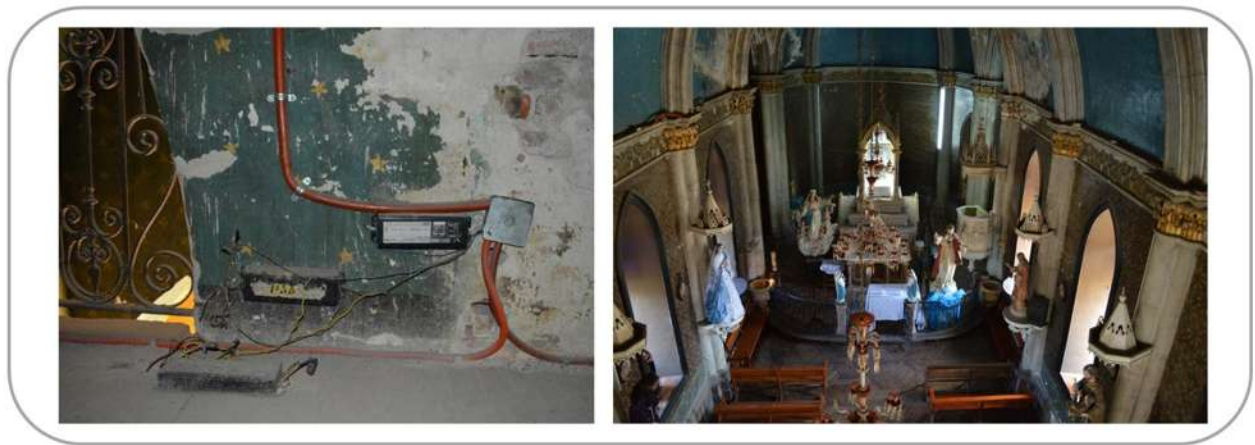
Fig.94: Red eléctrica expuesta. Fuente: Elaborado por Eliber Rieche Vilches.
