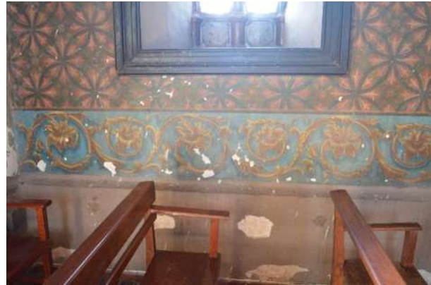
Fig.82: Terminación de pintura mural en muros interiores. Fuente: Fotografía tomada por el Autor.
