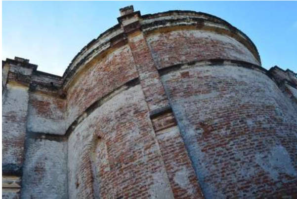
Fig.81: Sistema de aparejo de través o Tizón. Fachada trasera. Fuente: Fotografía tomada por el Autor.
