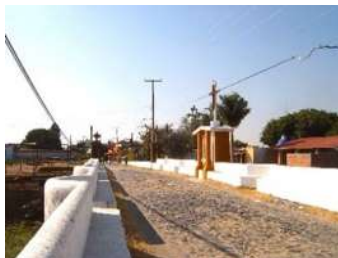
Fig.37 Puente de Piedra.
