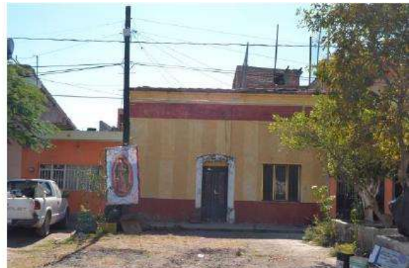
Fig.47 Vivienda sobre la calle Juárez. Fuente: Fotografía Actual tomada por el autor
