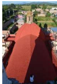
14- Cubierta de la capilla
