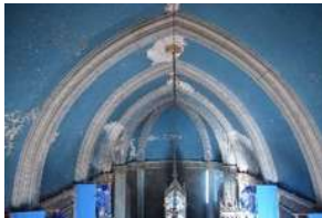
9- Bóveda de cañón
