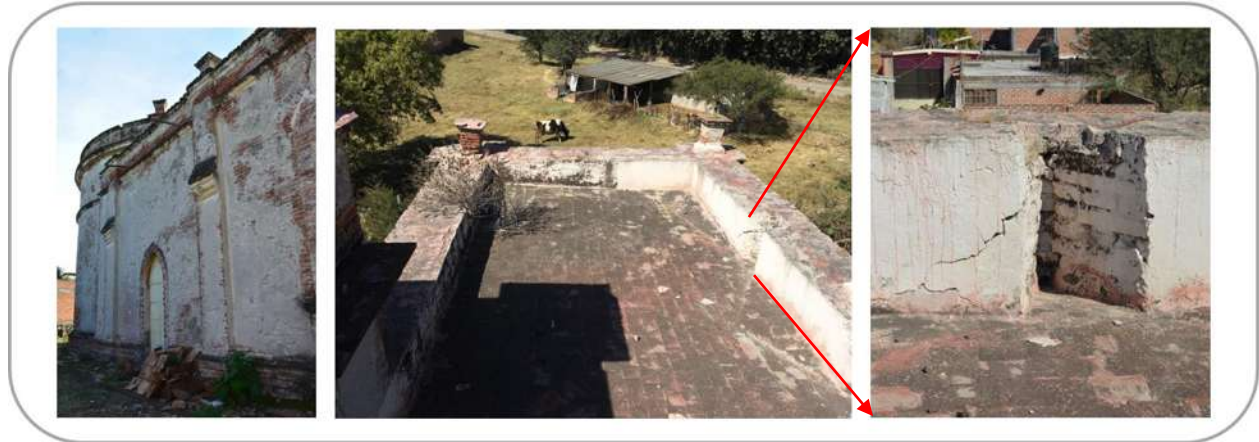
Fig.97 y Fig.98: Instalaciones de evacuación de aguas pluviales en fachada trasera y perforaciones para instalar tuberías de evacuación de aguas pluviales en pretilos, respectivamente. Fuente: Elaborado por Eliber Rieche Vilches.
