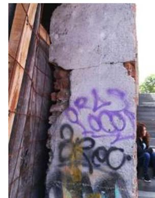
**Ilustración 70. Deterioro en aplanados y juntas.**
