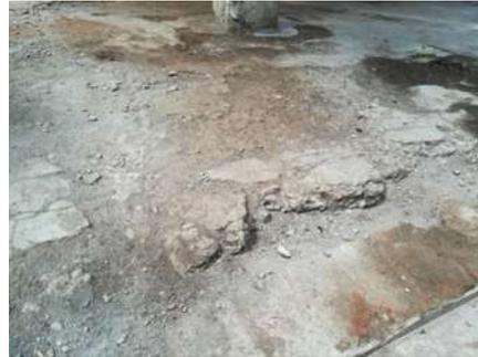
**Ilustración 66. Disgregación de material en pisos.**
