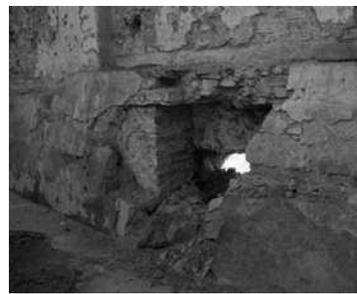
**Ilustración 73.** Disgregación de materiales y desprendimientos antrópicos.
