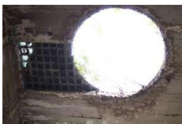
**Ilustración 87.** Orificios antrópicos en cubiertas.
