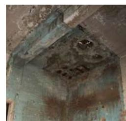
**Ilustración 79.** Deterioro en cubiertas.
