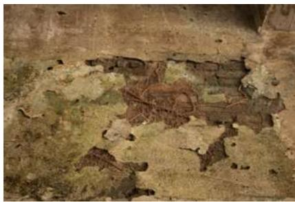
**Ilustración 72.** Raíces de flora parásita en muros.
