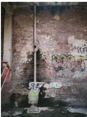
**Ilustración 67. Humedad y desprendimiento de aplanados.**
