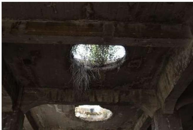
**Ilustración 61. Arcos deprimidos y maleza en aberturas de silos.**
