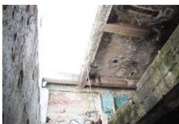
**Ilustración 78.** Flora parásita y eflorescencia en cubiertas.
