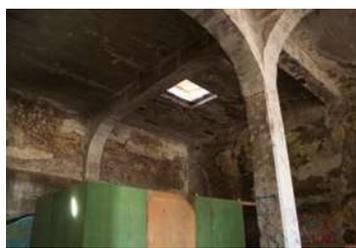
**Ilustración 76.** Flora, humedad y eflorescencia en cubiertas.
