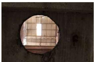
**Ilustración 75.** Orificios antrópicos en cubiertas.
