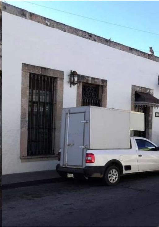
Fig.27. Aplano de mortero cal-arena.
