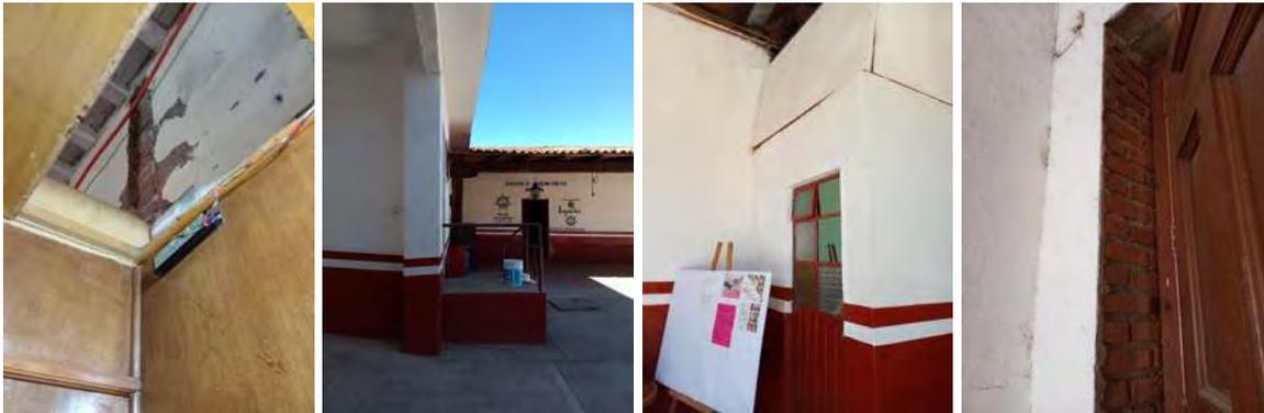
**Ilustración 54.** Aplicación y uso del tabique y cemento. De izquierda a derecha: pilar de tabique en crujía norte, apoyos, cerramiento y losa de concreto en acceso sur, muro de tabique y losa de concreto en anexo de sanitarios norte, pilar de tabique y trabe de concreto en acceso principal. Fotos: AMT.
