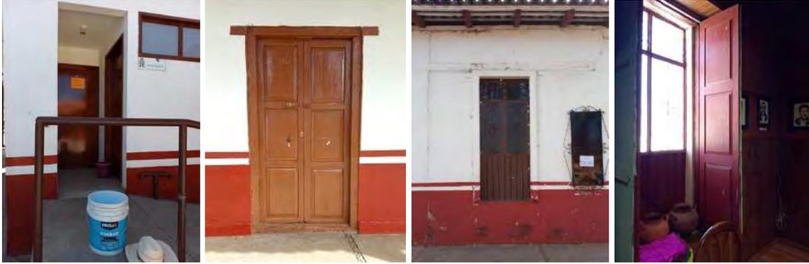
Ilustración 62. De izquierda a derecha: puerta de tambor y ventana de marco sencillo en sanitarios, puerta tablerada de portal, ventana de herrería de sala de juntas, contraventana tablerada en sala de juntas. Fotos: AMT.
