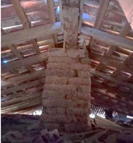
**Ilustración 52.** Foto de cubierta C-1, que muestra el sistema de apoyos de caballete mediante pilares de adobes. Obsérvese al fondo la cubierta C-2 que utiliza el mismo tipo de apoyos. Foto: AMT.
