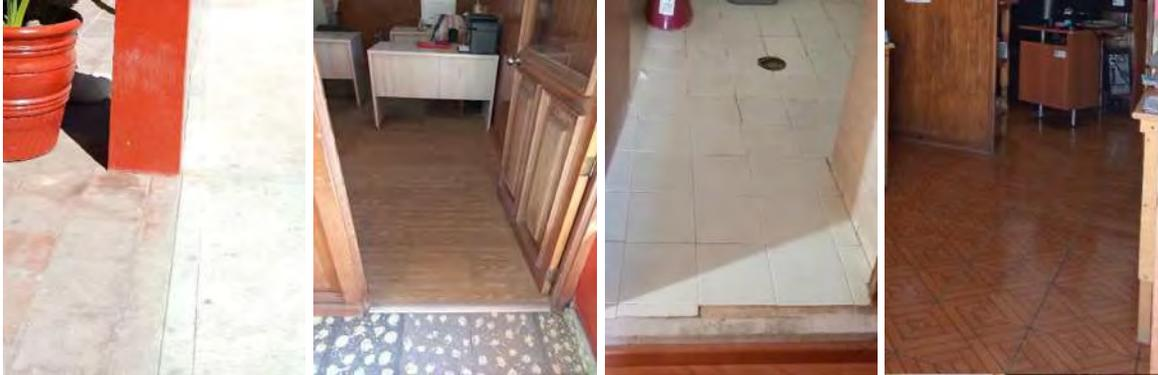
**Ilustración 60.** De izquierda a derecha: baldosa de barro y firme de concreto en patio / piso cerámico en corredor y piso laminado de oficinas norte / piso cerámico en baño norte / piso cerámico en oficinas poniente. Fotos: AMT.
