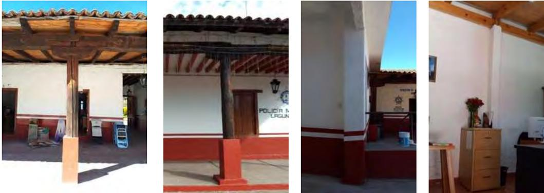
**Ilustración 57.** Apoyos aislados. De izquierda a derecha: apoyo de cubierta anexa / apoyo de cubierta de pórtico / columna de concreto en acceso / columna de concreto en anexo norte. Fotos: AMT.
