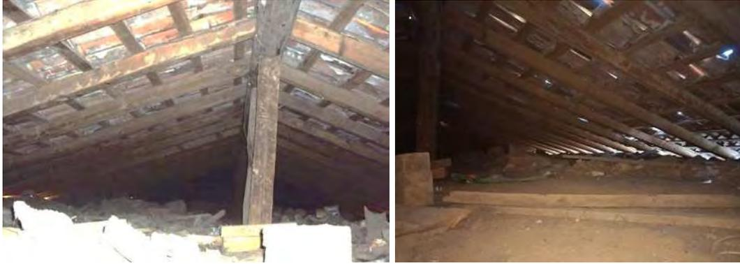
**Ilustración 59.** Fotos de tapanco de cubierta C-1, se muestra el sistema de apoyos de caballete mediante puntales, además de los componentes de cubierta, el terrado y al fondo el muro piñón de la fachada sur. Foto: AMT.
