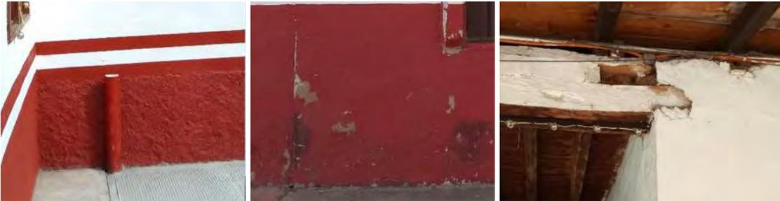
**Ilustración 61.** De izquierda a derecha: aplanado de cemento acabado rugoso y liso en muro medianero, aplanado de barro en fachada norte, aplanado de cemento en acceso peatonal. Fotos: AMT.
