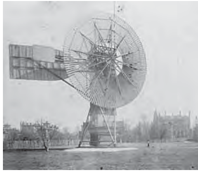
Figura 1.1 Primera turbina eólica para generar electricidad, 1888, Charles F. Brush, Cleveland, Ohio.
