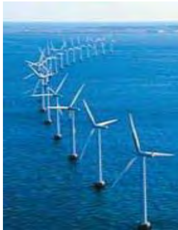
Figura 1.3 Parque eólico marino
