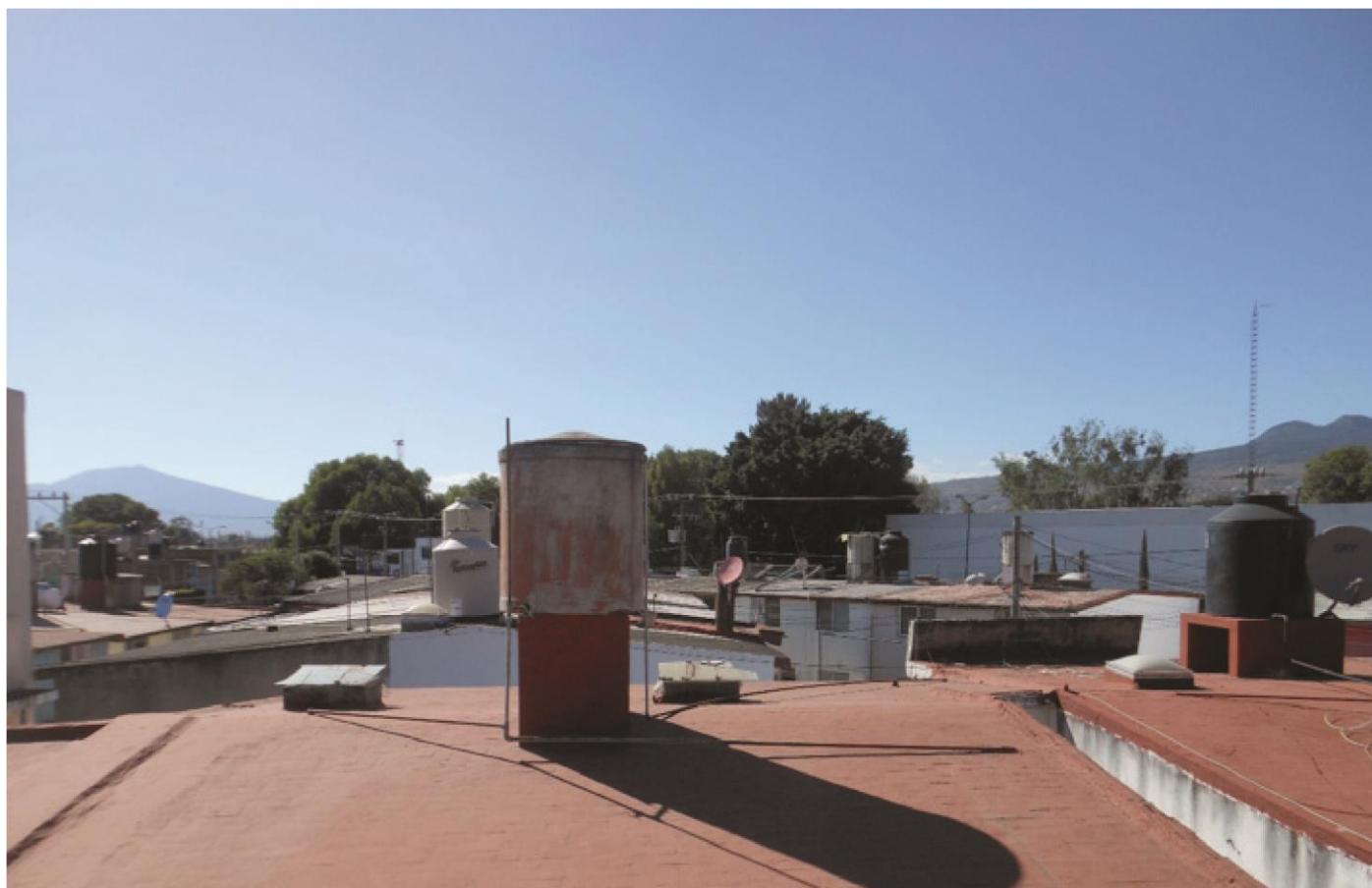
Azoteas en la ciudad de Morelia, sin diseño de captación de agua de lluvia. Foto: Julio César Camarena Tello
