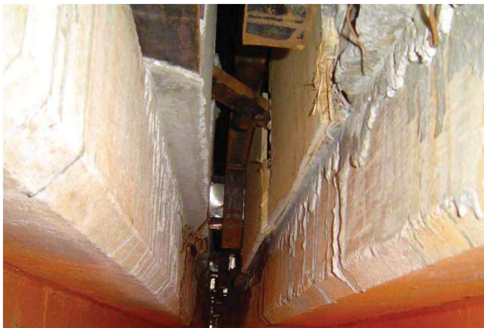
Figura 4-3. Mecanismo de juntas sísmicas.
