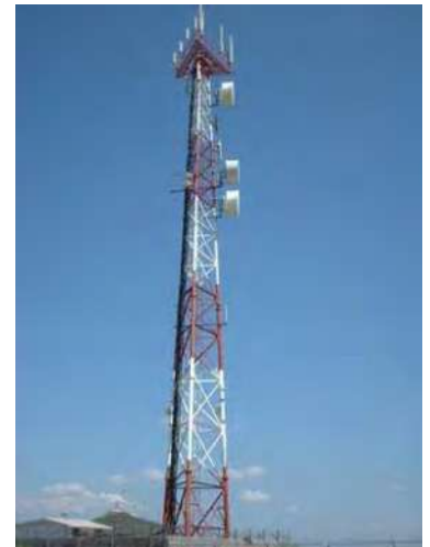
(a) Panorámica de una torre
