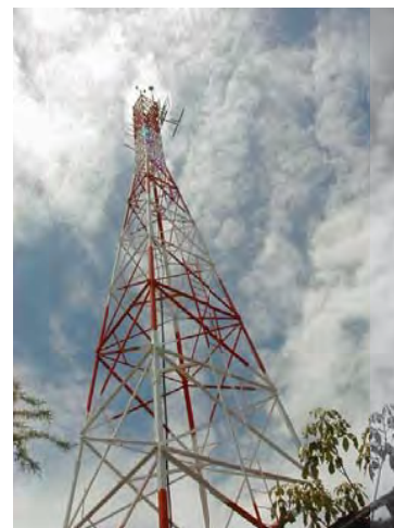
(a) Panorámica de una torre
