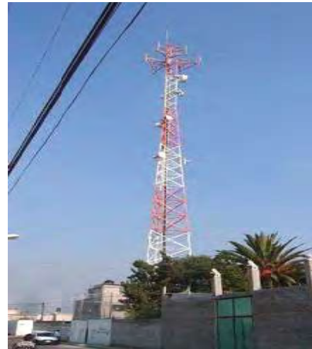
(a) Panorámica de una torre
