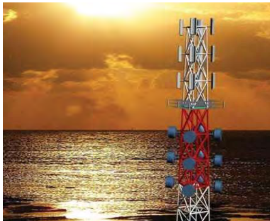
Figura 3.3.4 Antenas y plataforma de trabajo en las torres Tipo 1
