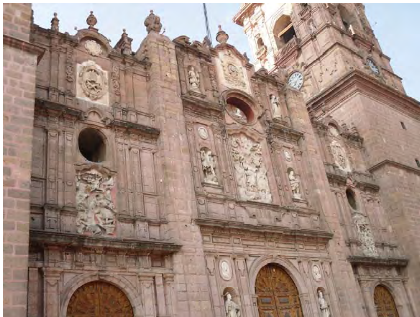
Figura 3.2. Fachada norte de la Catedral de Morelia.
