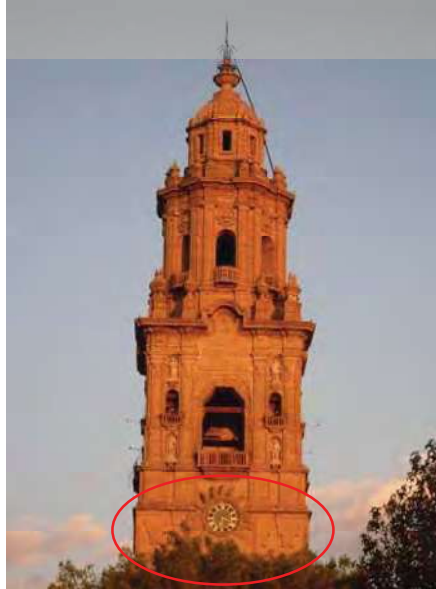
Figura 3.8. Configuración de la torre poniente.
