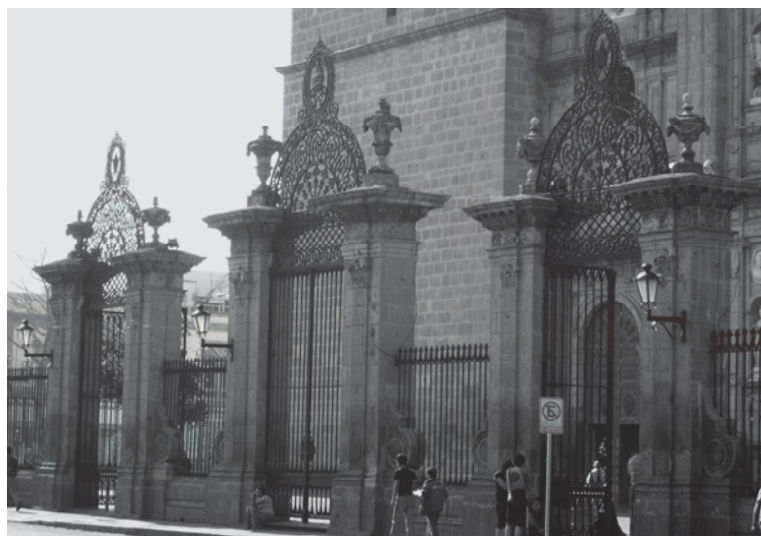
Figura 3.4. Reja principal, fachada norte.
