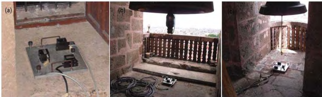
Figura 4.3 a) Placa Uno, muro frontal. b) Placa Dos, primer campanario. c) Placa Tres, segundo campanario.
