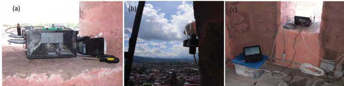
Figura 4.8 a) Equipo ETNA. b) Antena GPS. c) Estación sísmica.
