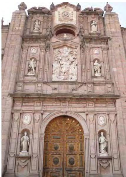
Figura 3.5. Portada central, fachada norte.
