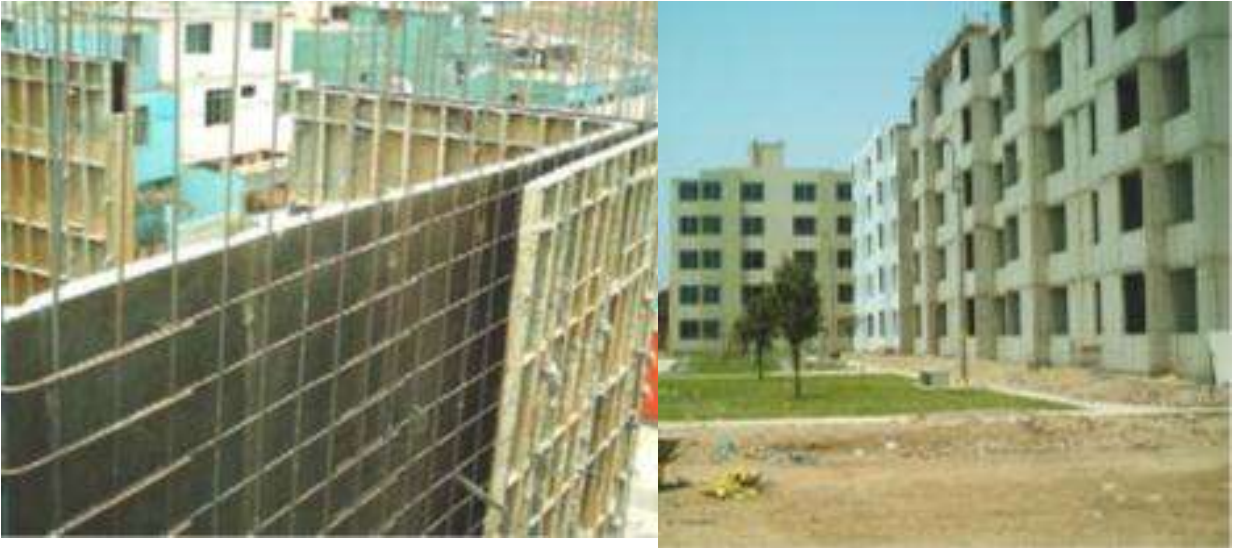
(a) Acero de refuerzo.
