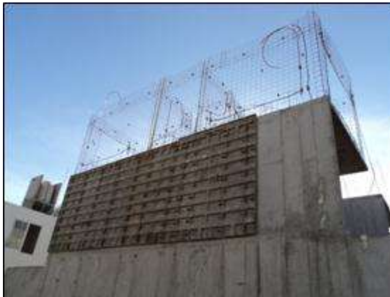
Figura 1.2. Vivienda de 3 niveles con malla electro soldada.
