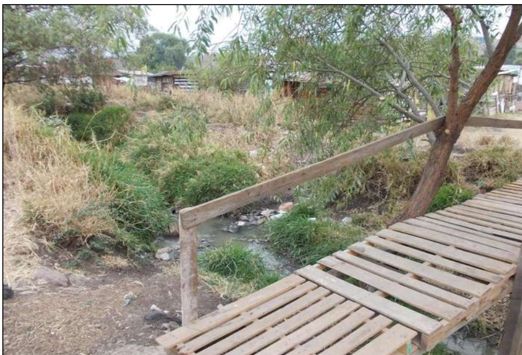
Foto 9. Canal y puente
