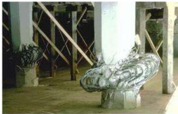
**Figura 2.13** Falla de columna durante el terremoto de Northridge. Fuente: <http://earthquake.usgs.gov/bytopic/photos.html>
