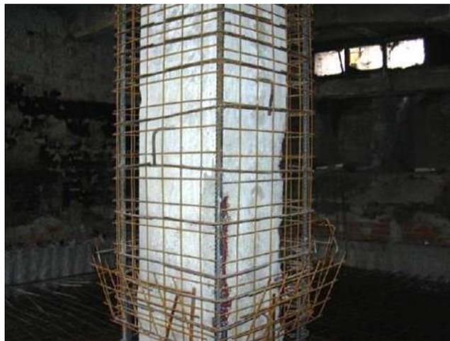
**Figura 2.9** Preparación de la superficie antes de colar la nueva capa de concreto. Tomada de Cosmin et al. (2009).
