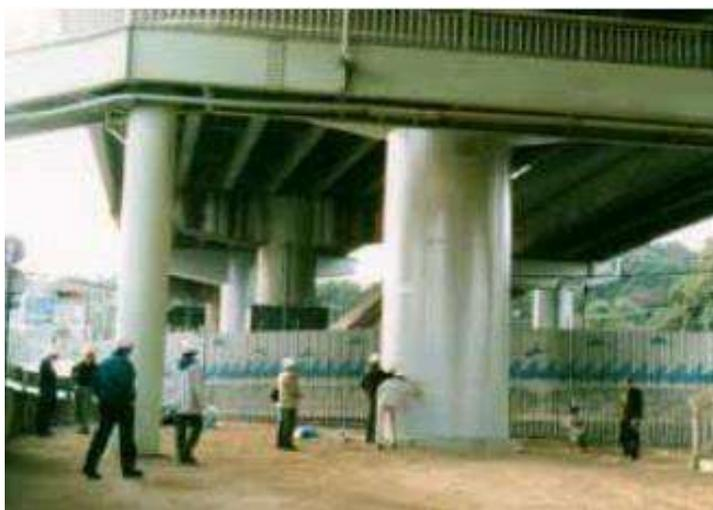
**Figura 2.10** Refuerzo de pila con encamisado de acero en Hanshin, Japón. Fuente: [seismic.cv.titech.ac.jp](http://seismic.cv.titech.ac.jp)
