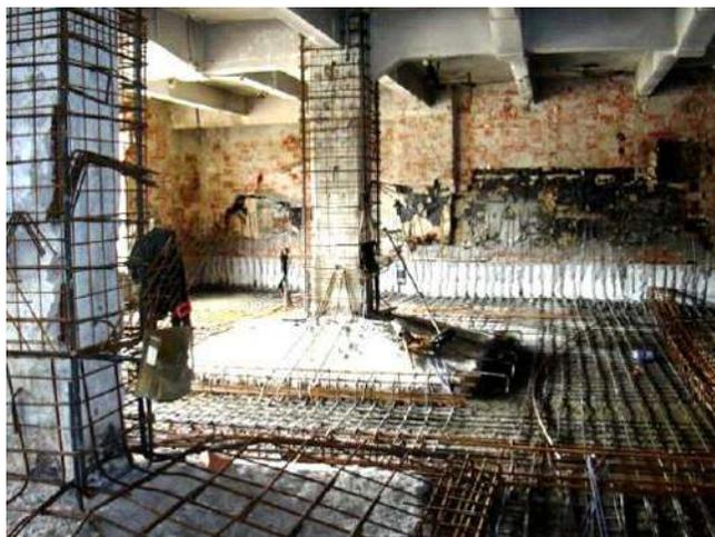
**Figura 2.8** Refuerzo mediante encamisado de concreto. Tomada de Cosmin et al. (2009).
