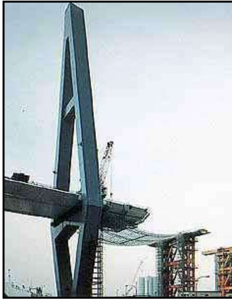
FIG 1.5 PILA EN TIPO "A" ( http://puentes.galeon.com/tipos/imgtipos/pontst1.jpg )
