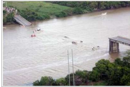
Figura 3. Colapso del puente Tonalá [Tomada de Aguado, 2012]
