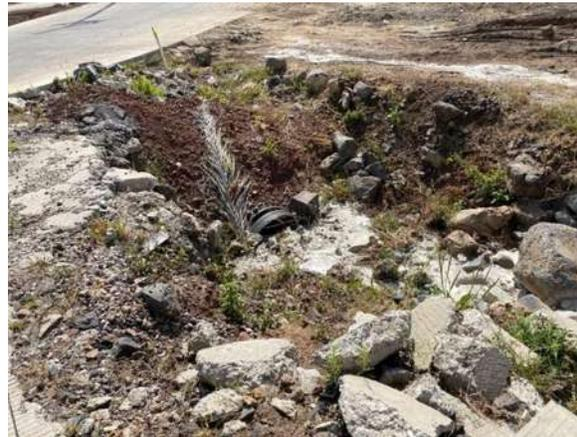
Figura 26 Obstrucción de la tubería en la parte alta del canal.
