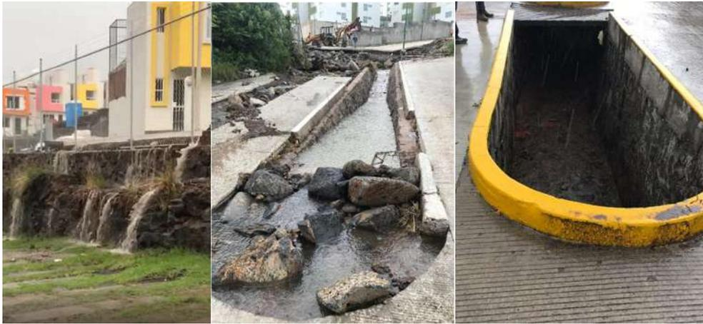
Figura 18 Sistema de drenaje pluvial deficiente
