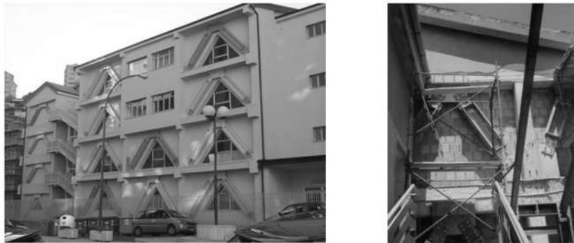
Figura 1.10 Escuela Viola Domiziano en Potenza Italia (Zona sísmica I), reforzado en 2000 con contravientos y dispositivos de disipación de energía, (Martelli, 2008)
