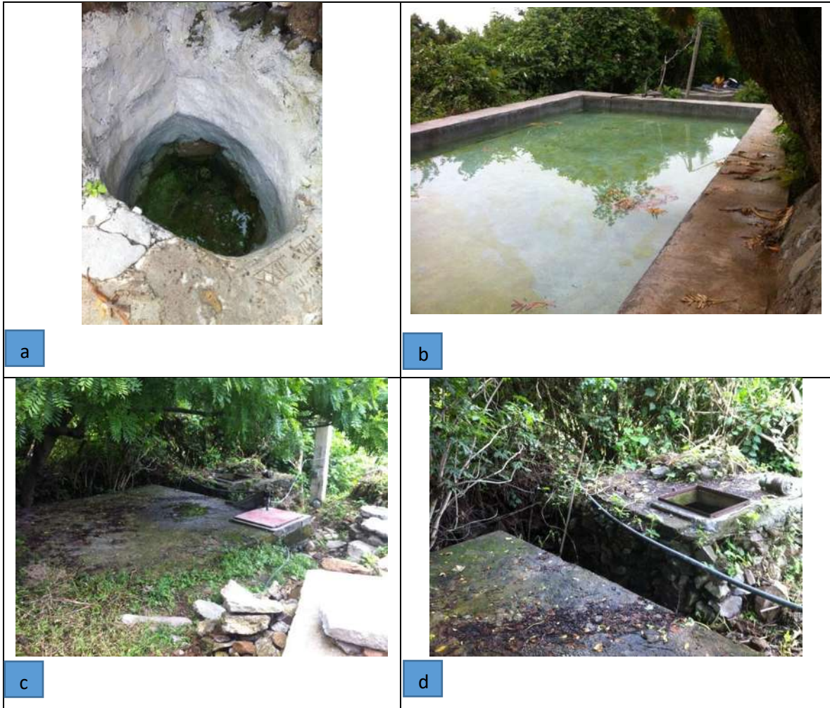
Figura 16. a) Manantial “Ojo de agua”, fuente natural de agua en la localidad. b) “La Pila” primera construcción para el acopio del agua que nace del manantial y al fondo se colocaron lavaderos de uso comunitario. c y d) Cisterna que colecta el agua y bombea al depósito para distribución.
