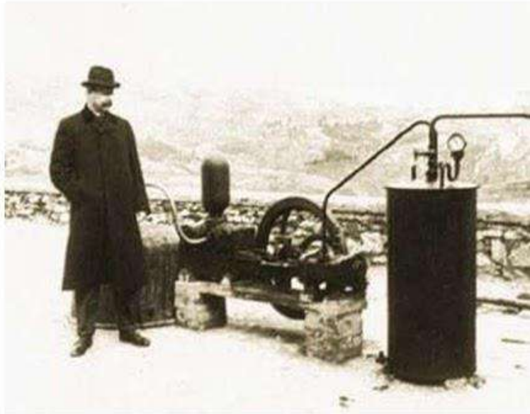
Figura 14. Maquina usada en Larderello en 1904 para la generación de energía eléctrica mediante vapor caliente, con su inventor el Principe Piero Ginori.
