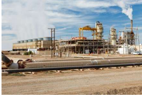
FIGURA 6. Sistema geotérmico geopresurizado en Bayou, Texas. Se trata de agua salada caliente saturada con gas natural bajo alta presión.
