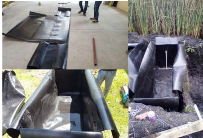
Figura 17. Proceso de geomembrana
