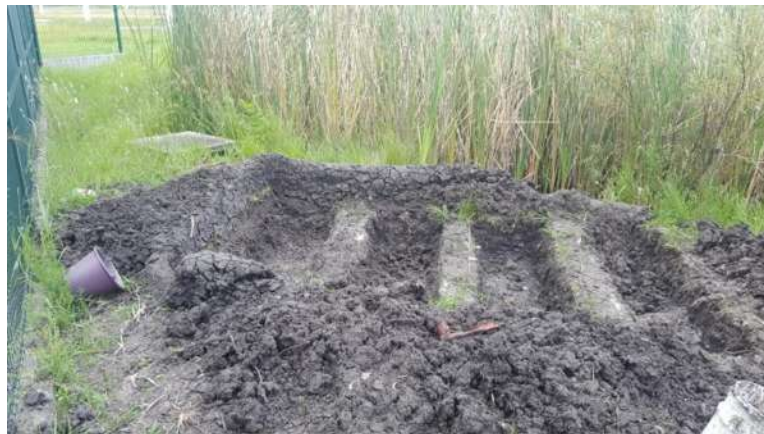
Figura 14. Zanjas para colocación de los modelos
