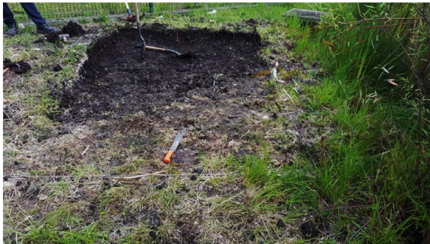
Figura 12. Terreno nivelado y despalme
