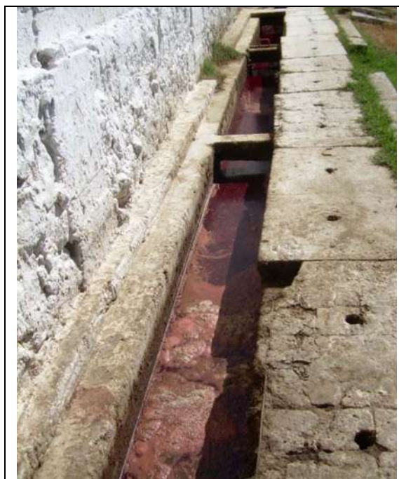
Figura 4.1. Canal de desagüe de las aguas residuales del rastro.
