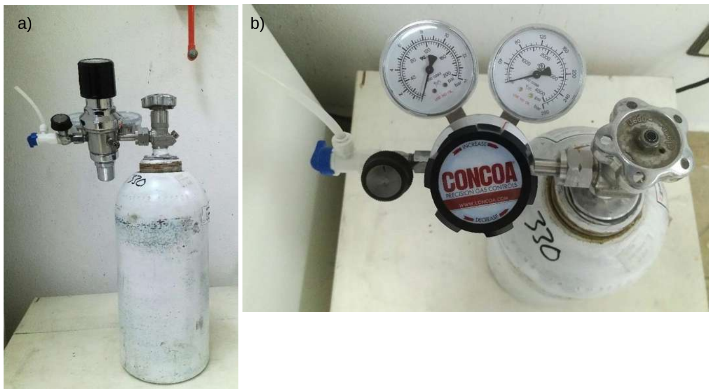
Figura 3.3 Tanque de biogás. a) Vista frontal. b) Vista superior
