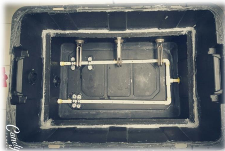
Figura 10. Vista del interior del reactor UASB
