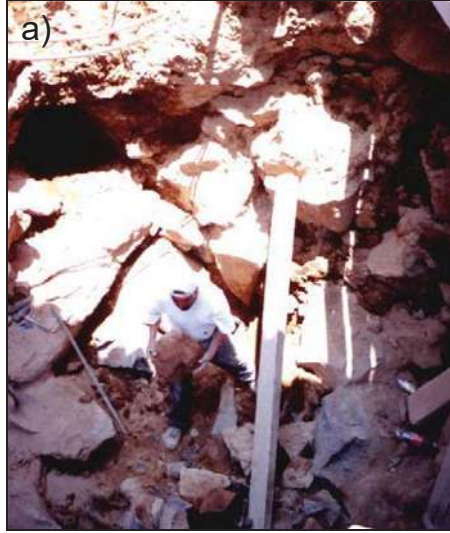
Figura 4.3.1.3.- Excavación en calle Espejo, a) aspecto general de la excavación en donde se puede apreciar el tamaño de las rocas, así como su forma, b) detalle de la prueba de resistencia con esclerómetro.
