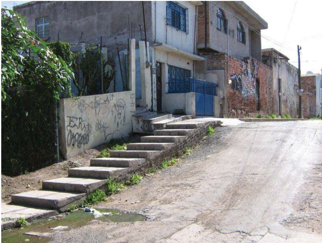
Figura 25b. Daños ocasionados por la falla Oriente.
