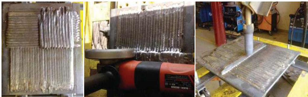
Figura 2.4. Secuencia de aplicación del recargue de acero inoxidable martensítico 410.
